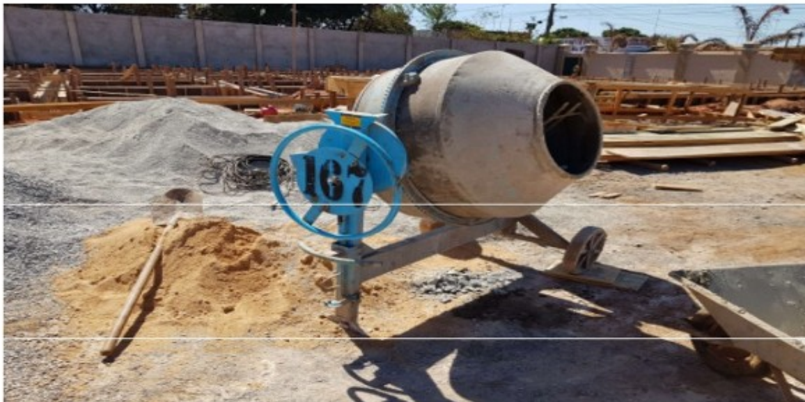
Figura 7: betoneira sem aterramento elétrico de sua carcaça.
