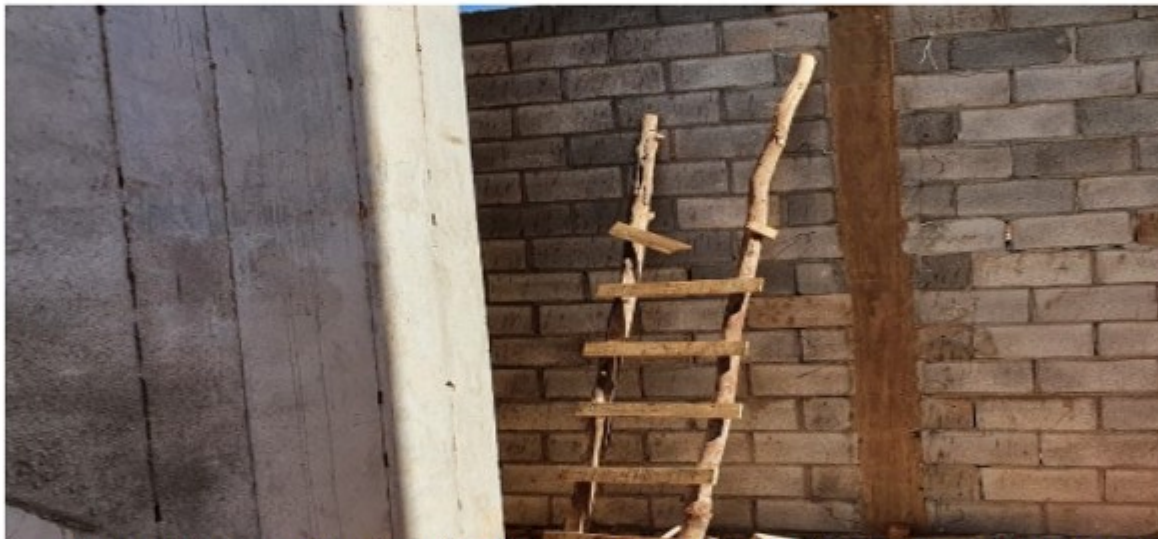
Figura 18: escada de mão de madeira construída de forma improvisada
