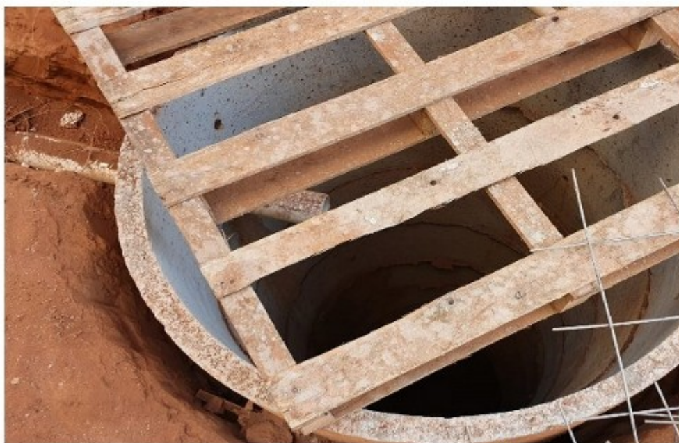
Figura 20: Abertura no piso sem a devida proteção.
