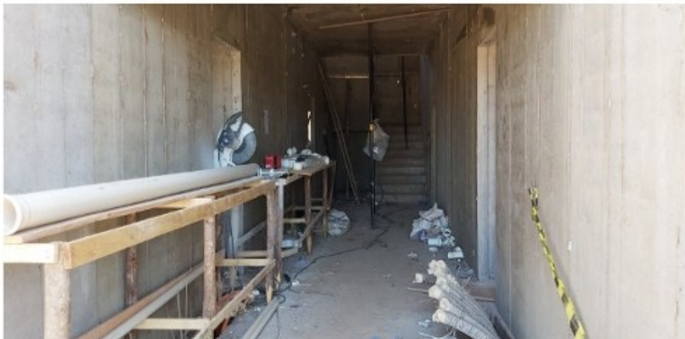
Figura 1: bancada para a realização de dobragem e corte de vergalhões de aço.
