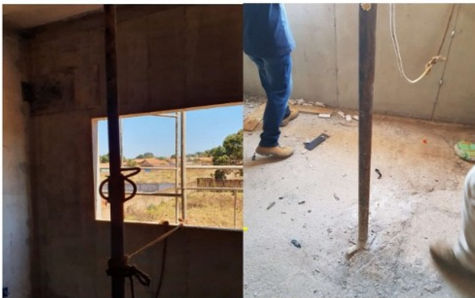
Figuras 5 e 6: andaime não fixado na estrutura da edificação.
