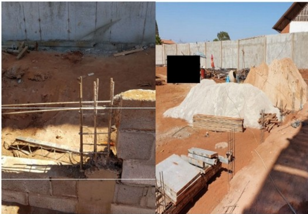
Figuras 16 e 17: pontas verticais de vergalhões desprotegidas.
