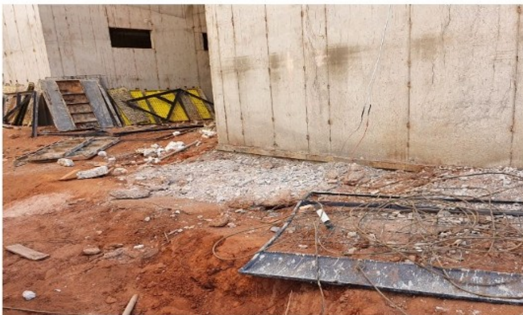
Figura 15: condutores elétricos obstruindo a circulação de pessoas e materiais e com outras desconformidades.
