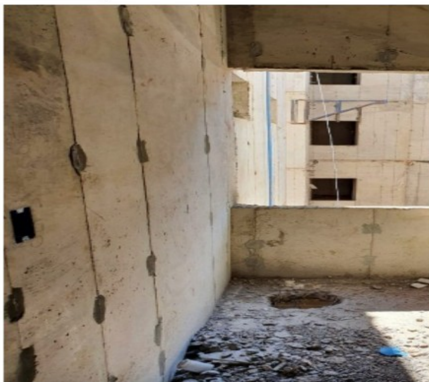
Figura 19: Abertura sem proteção na periferia da edificação.
