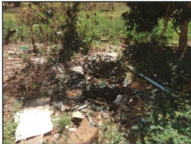
Fossa situada logo ao lado da casa, com sinais de afundamento e precariamente coberta com pedaços de tábuas e lonas.
