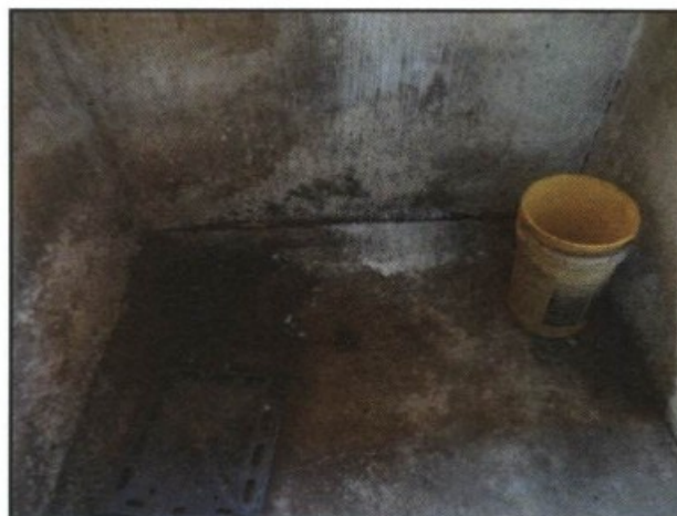
Paredes e piso do banheiro mofados e deteriorados, sem revestimento.
