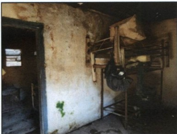
Paredes da casa em precário estado de conservação, com infiltração e mofo.
