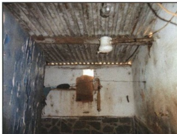
"Janela" do sanitário, consistente em um buraco na parede, tampado por um pedaço de papelão. Paredes em precário estado, sem revestimento completo.
