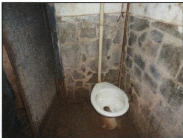
Vaso sanitário quebrado e paredes, piso e porta em precário estado de conservação e de higiene.
