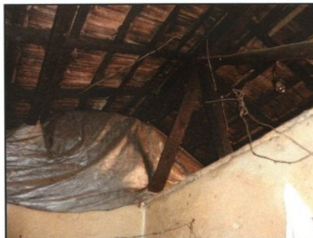
Detalhe das lonas e das gambiarras elétricas.
