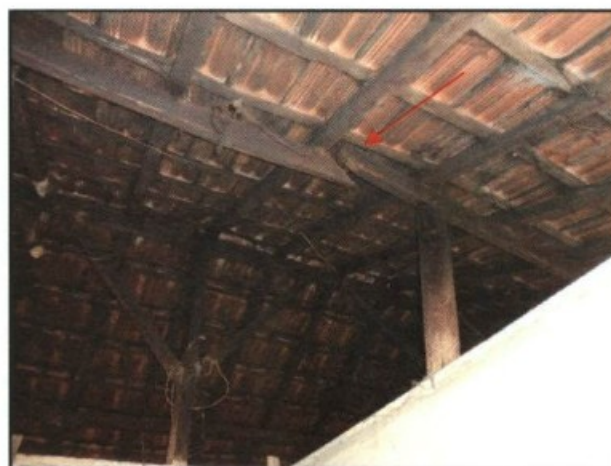
Telhado com viga quebrada.
