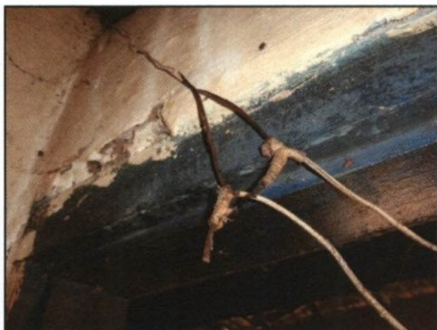
Amostra de uma das gambiarras elétricas: fiação precariamente emendada.
