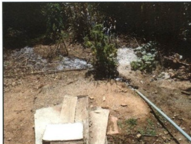
Esgoto do tanque e pia vertido ao lado da casa, formando uma poça de detritos.
