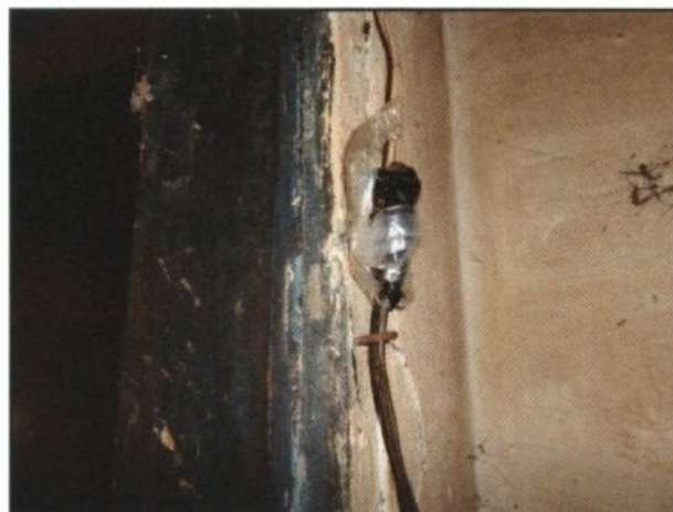
Emenda "isolada" com pedaço de plástico.
