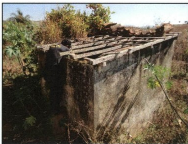
Reservatório de água em alvenaria, sem telhado, sem revestimento.
