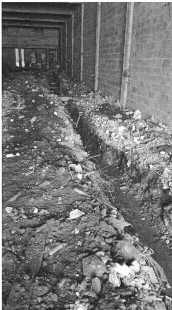
13/07/2016 – Canteiro de Obras localizado na Rua Magarinos Torres, 773/775, Vila Maria, São Paulo, SP. Aberturas do piso no pavimento térreo da obra não dotadas de fechamento provisório.
