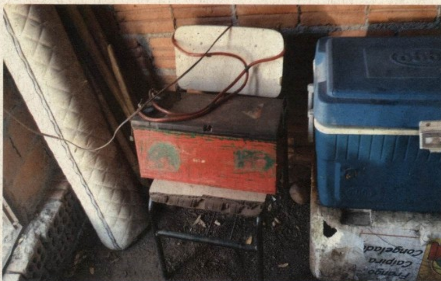
Foto: Bateria descarregada, com fiação elétrica precária, envolta por ambiente marcado pela sujeidade
