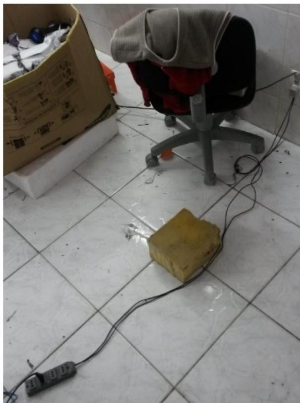
06/05/2016 – [REDACTED] . Ligações elétricas improvisadas no setor produtivo. Desconformidade com a Norma Regulamentadora 10 – Segurança em Instalações e Serviços em Eletricidade e com a Norma Brasileira NBR 5410/1995 – Instalações Elétricas de Baixa Tensão.
