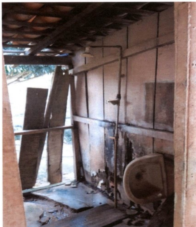
Detalhe: valas no piso; acúmulo de água; pia sem condições de uso. Falta de paredes.
