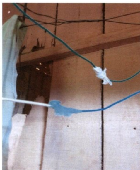
Fogareiro de barro ligado à parede de tábua/fios elétricos energizados emendados com sacos plásticos.
