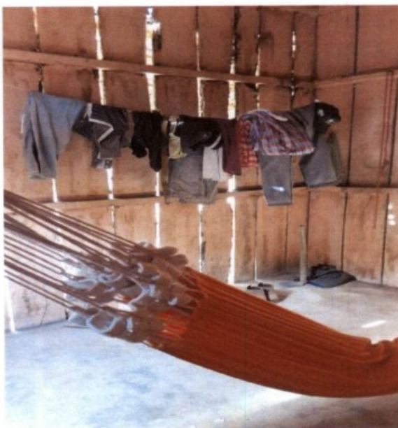
Fotografias de um dos cômodos. Detalhe para as frestas na parede.
