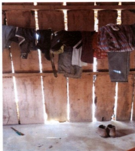
Fotografias de um dos cômodos. Detalhe para as frestas na parede.
