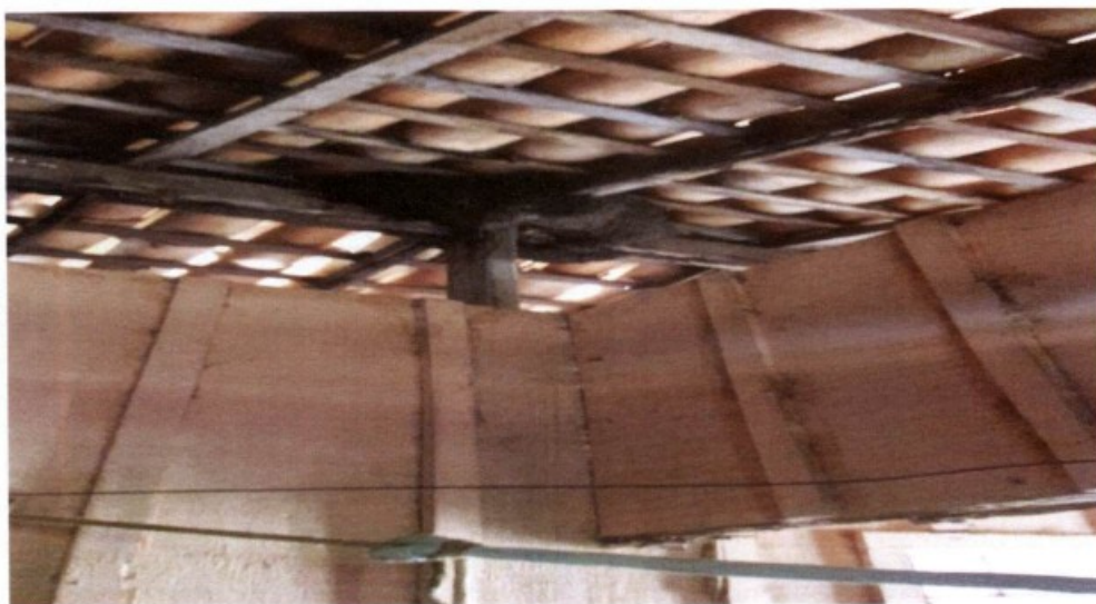
Cupins na estrutura do teto do barracão.
