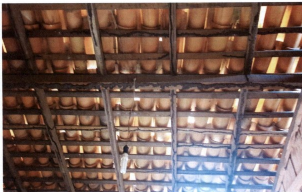
Cupins espalhados em toda a estrutura do teto (terças, caibos, ripas)
