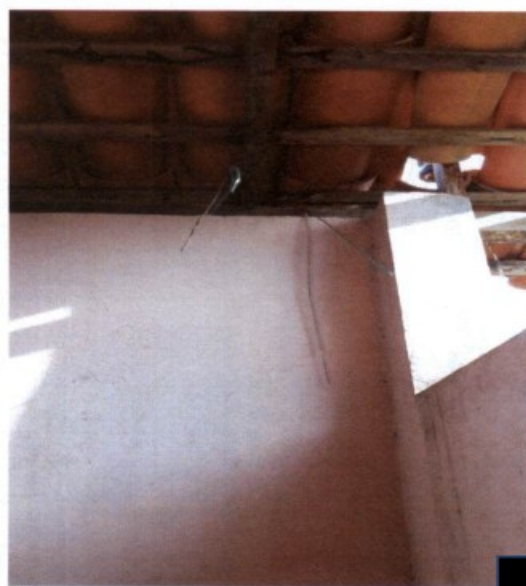
Banheiro que fica a 60 m do barracão: fiação elétrica energizada em condições inseguras.
