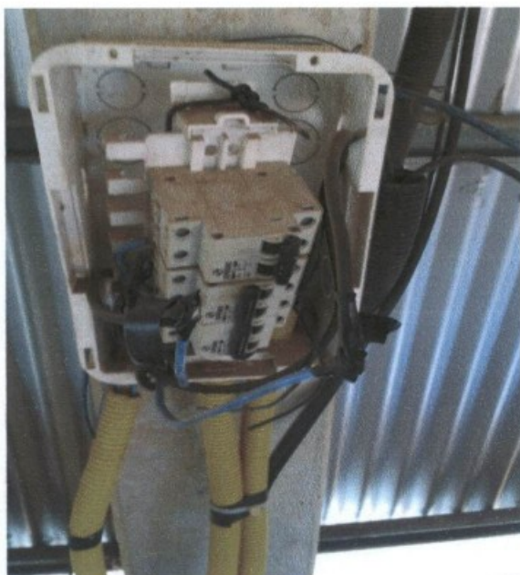
Fotos 01 e 02: Rede Elétrica desprotegida.
