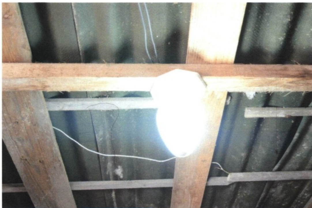
09.12.2015 – Alojamento de [REDACTED] Telhado com estrutura inadequada e com falhas; rede elétrica improvisada e desprotegida.
