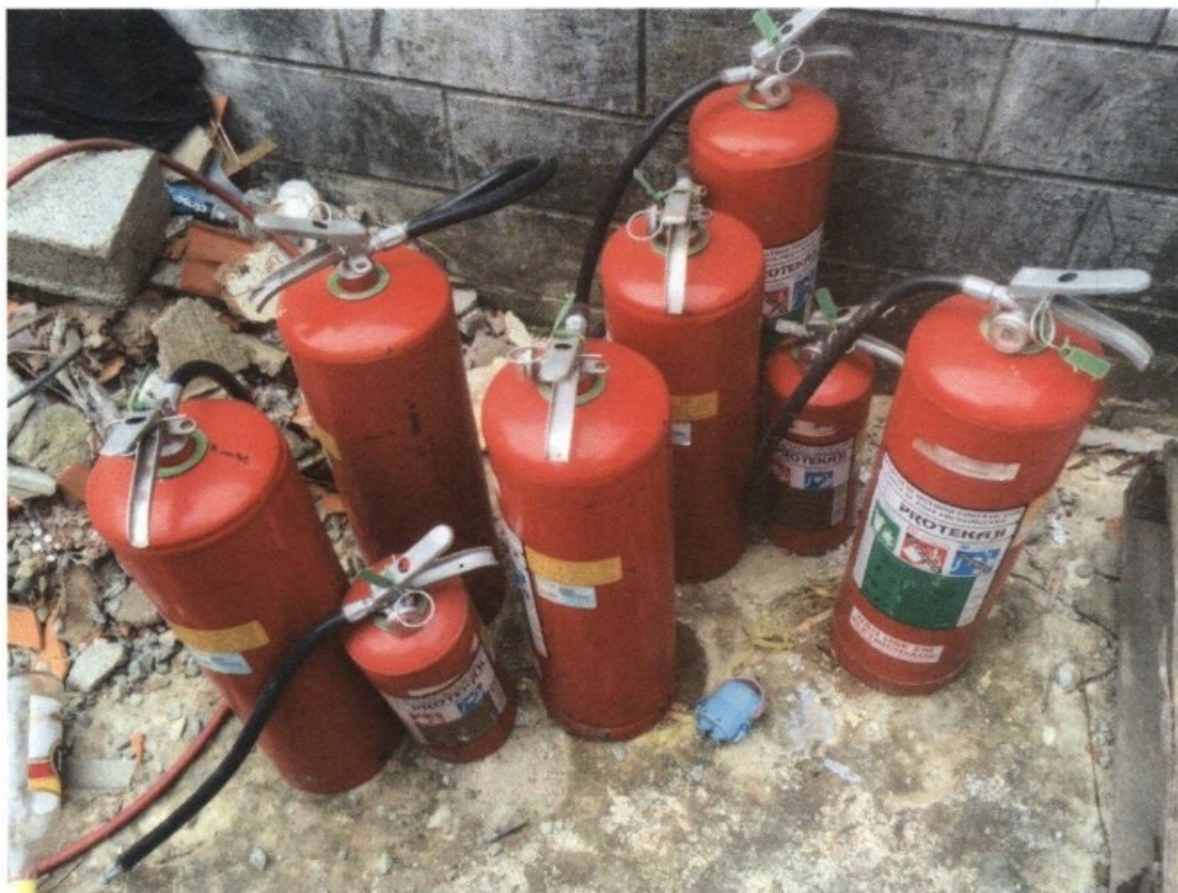
09.12.2015 – Extintores de incêndio vencidos, sem manutenção e descarregados.
