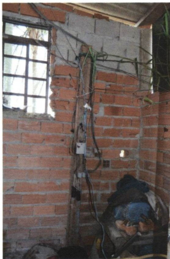
09.12.2015 - Ligações elétricas totalmente improvisadas, com risco grave e iminente de choques elétricos. Denota-se também nesta imagem que falhas nas paredes fazem com que o mato adjacente entre dentro da casa de máquinas, invadindo e se juntando às instalações elétricas.
