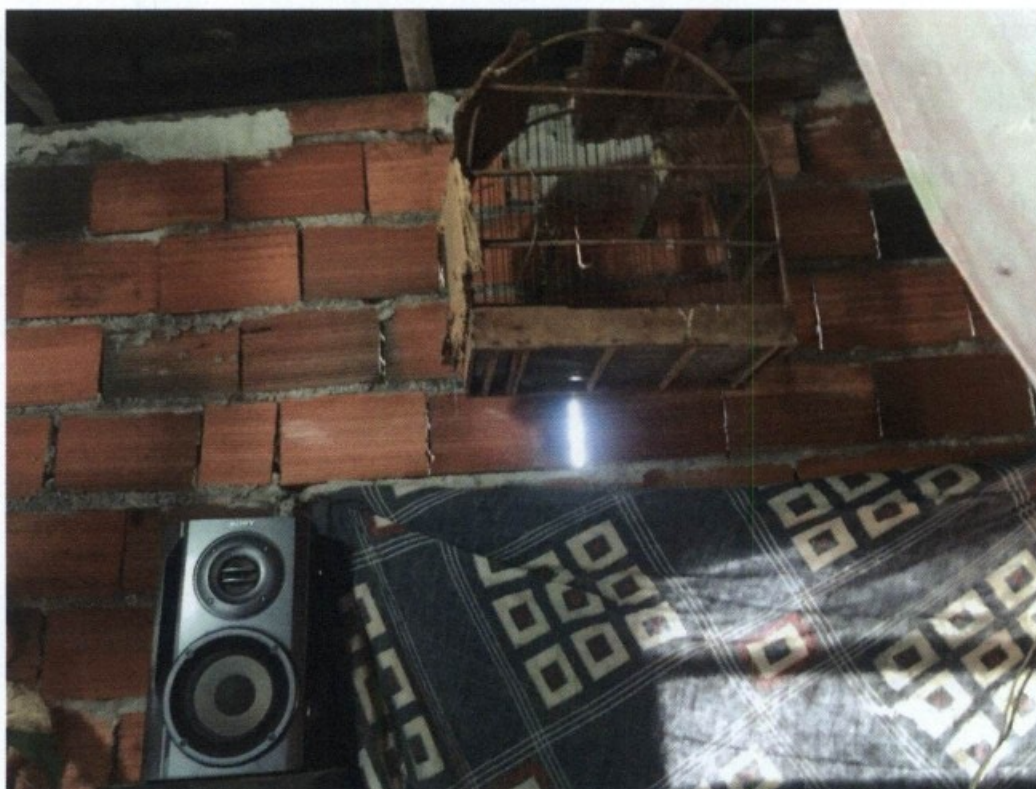
09.12.2015 – Paredes do alojamento com falhas e aberturas, permitindo a entrada de insetos e roedores e não protegendo adequadamente contra intempéries.
