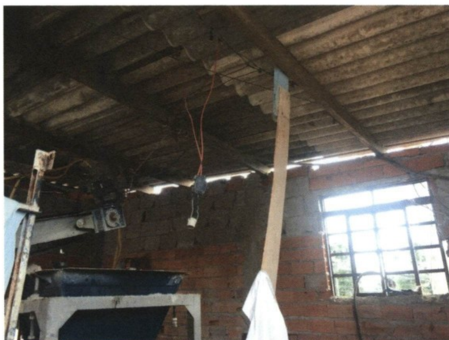
09.12.2015 - Ligações elétricas totalmente improvisadas, com risco grave e iminente de choques elétricos. Denota-se também que a casa de máquinas possui falhas na cobertura e paredes, além da janela aberta, o que favorece a entrada de água e não protege as máquinas e as fiações elétricas de intempéries.
