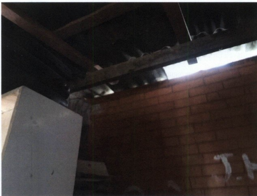
09.12.2015 – Cobertura do alojamento com falhas e aberturas, permitindo a entrada de insetos e roedores e não protegendo adequadamente contra intempéries.
