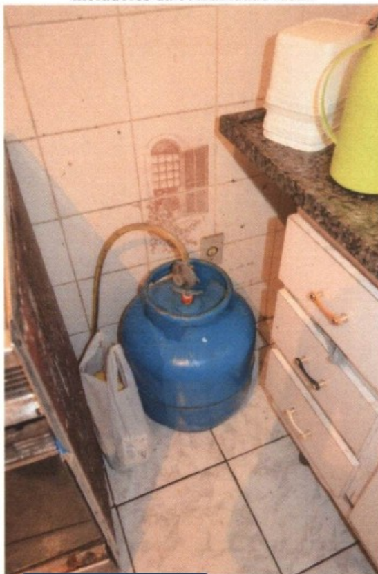
09.12.2015 – Alojamento de [REDACTED]. Botijão de gás liquefeito de petróleo instalado em local inadequado, sem ventilação adequada, oferecendo risco de explosão aos ocupantes do alojamento.
