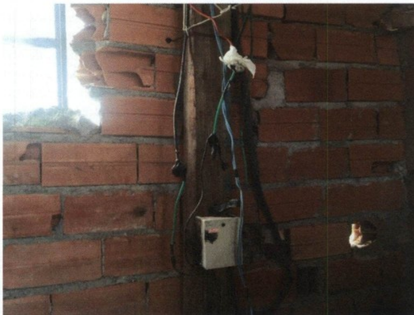
09.12.2015 – Fios de energia sem proteção, expostos e com ligações irregulares: risco grave e iminente de choques elétricos.
