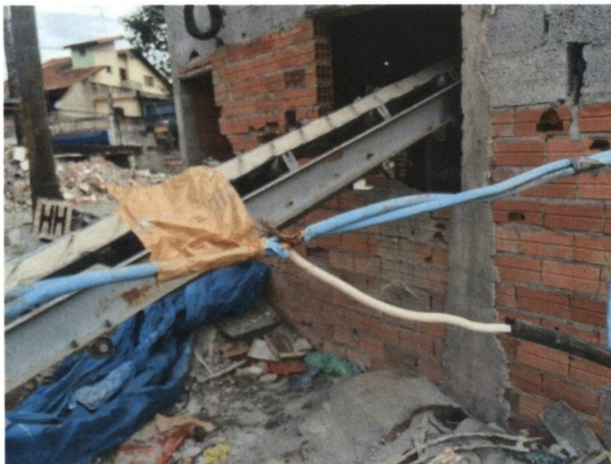
09.12.2015 - Ligações elétricas totalmente improvisadas, com risco grave e iminente de choques elétricos.
