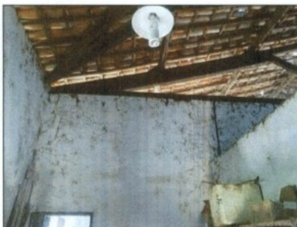
Fotos: Aberturas entre as paredes e o telhado, no interior do depósito de agrotóxicos.
