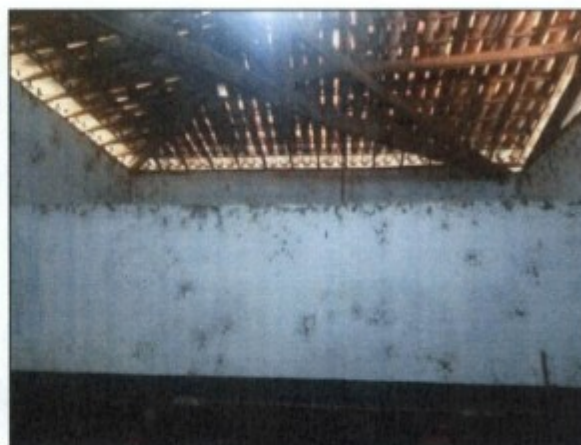
Fotos: Aberturas entre as paredes e o telhado, no interior do depósito de agrotóxicos.
