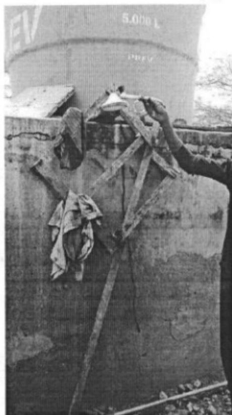
Foto 26: Chuveiro plástico com água vinda da caixa de água.
