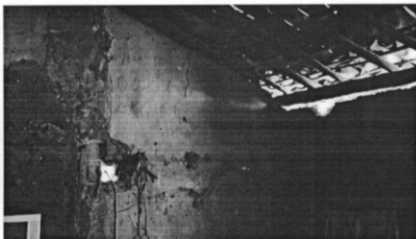
Foto 23: Interior do alojamento, paredes em taipa.
