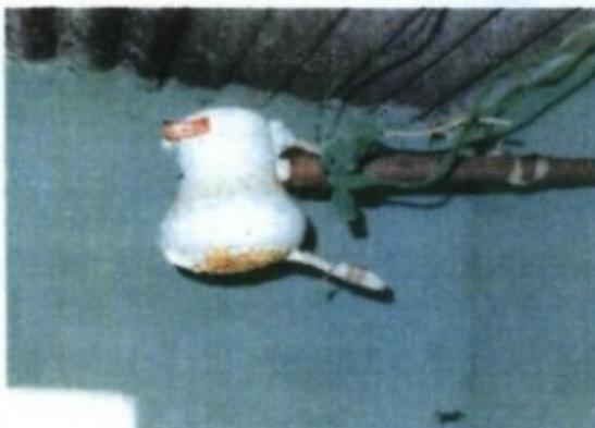
Figura 7 – Chuveiro da edificação 3, com condutores elétricos isolados improvisadamente com sacola plástica.
