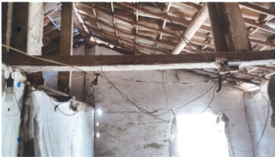
Foto 2: Instalações elétricas precárias
