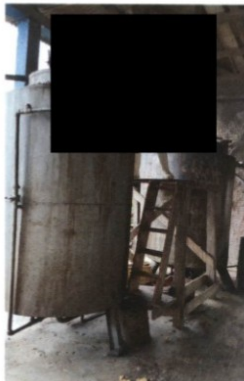
Acesso à estrutura da caldeira ( andaime com escada de acesso e plataforma, todos de madeira)
