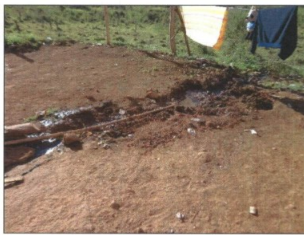
Detalhe do esgotamento das águas servidas da cozinha e do tanque, formando uma poça de detritos logo à entrada da casa.
