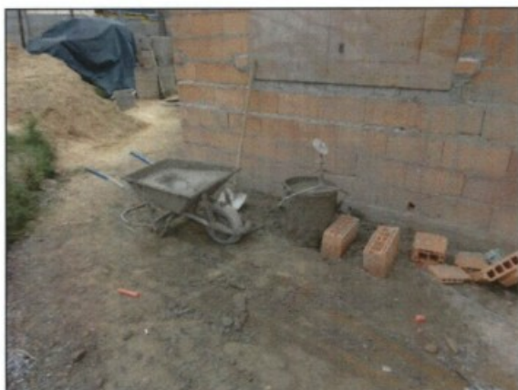
Área sob o guincho de coluna, sem isolamento e sinalização.
