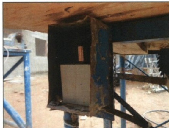
Detalhe da chave de acionamento, com livre acesso e sem bloqueio de acionamento automático na reenergização.
