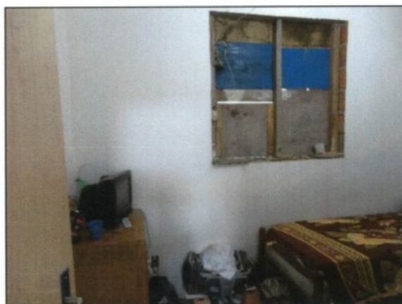
Detalhe da vedação do vão da janela no primeiro dormitório.
