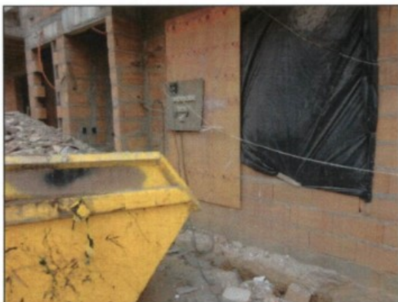
Um dos quadros de energia da obra, sem qualquer proteção contra impactos e umidade.
