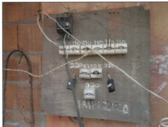
Detalhe do mesmo quadro, com tomadas sem plugue e partes vivas expostas em disjuntor.
