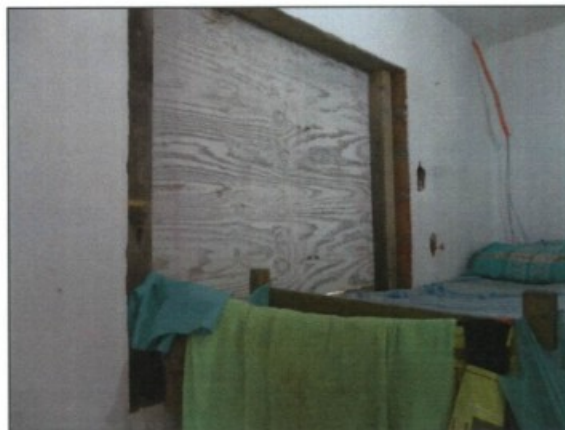
Detalhe da vedação do vão da janela no segundo dormitório.
