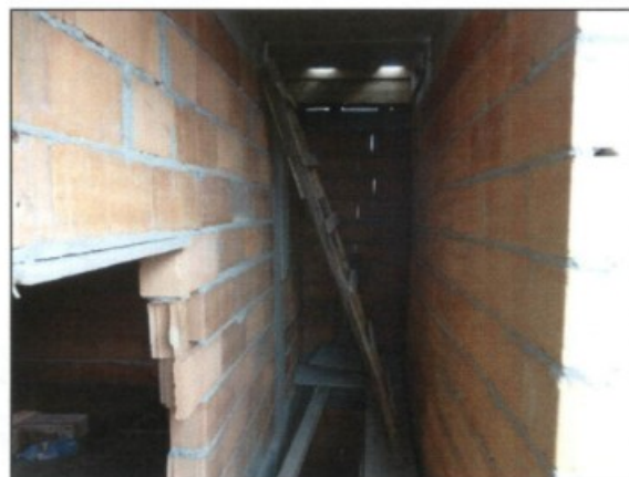
Escada de mão utilizada próximo de vão, com risco de queda.
