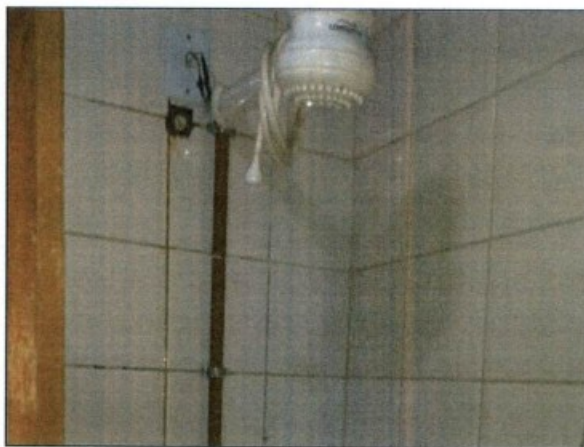
Fotos: Instalações elétricas desprotegidas no chuveiro e na fiação dos ventiladores.
