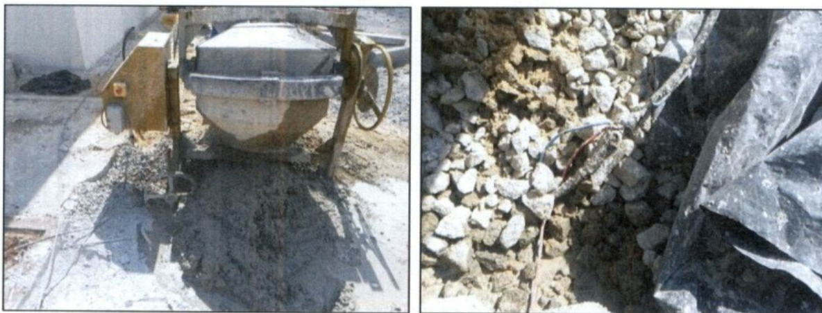
Fotos: Betoneiras encontradas na obra, com fios expostos e em contato com umidade.
