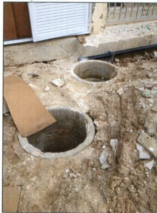
Fotos: Aberturas no piso encontradas em diversos locais do canteiro de obras.
