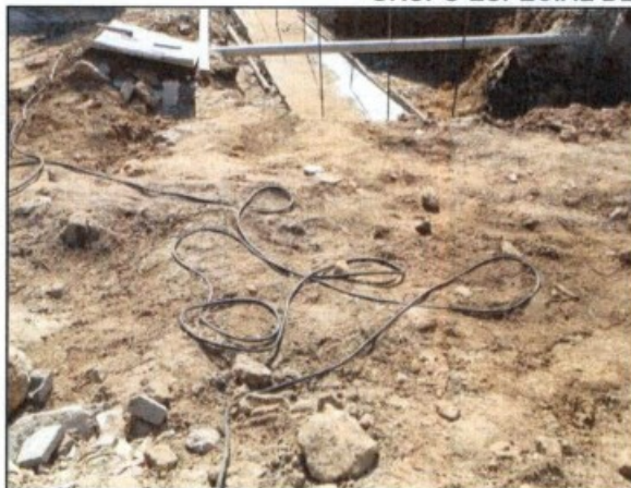
Fotos: Condutores de eletricidade espalhados e desprotegidos, pelo chão da obra.
