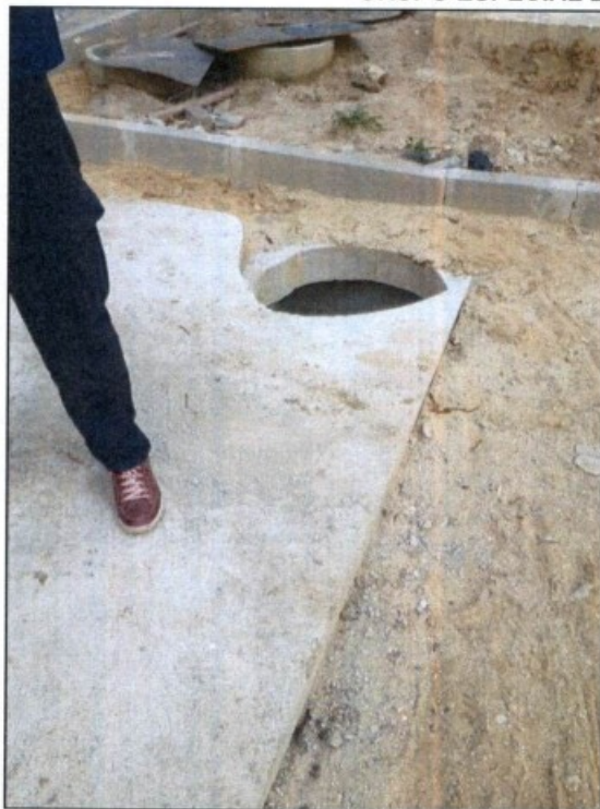
Fotos: Aberturas no piso encontradas em diversos locais do canteiro de obras.
