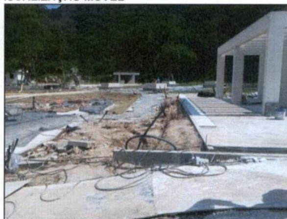
Fotos: Condutores de eletricidade espalhados e desprotegidos, pelo chão da obra.
