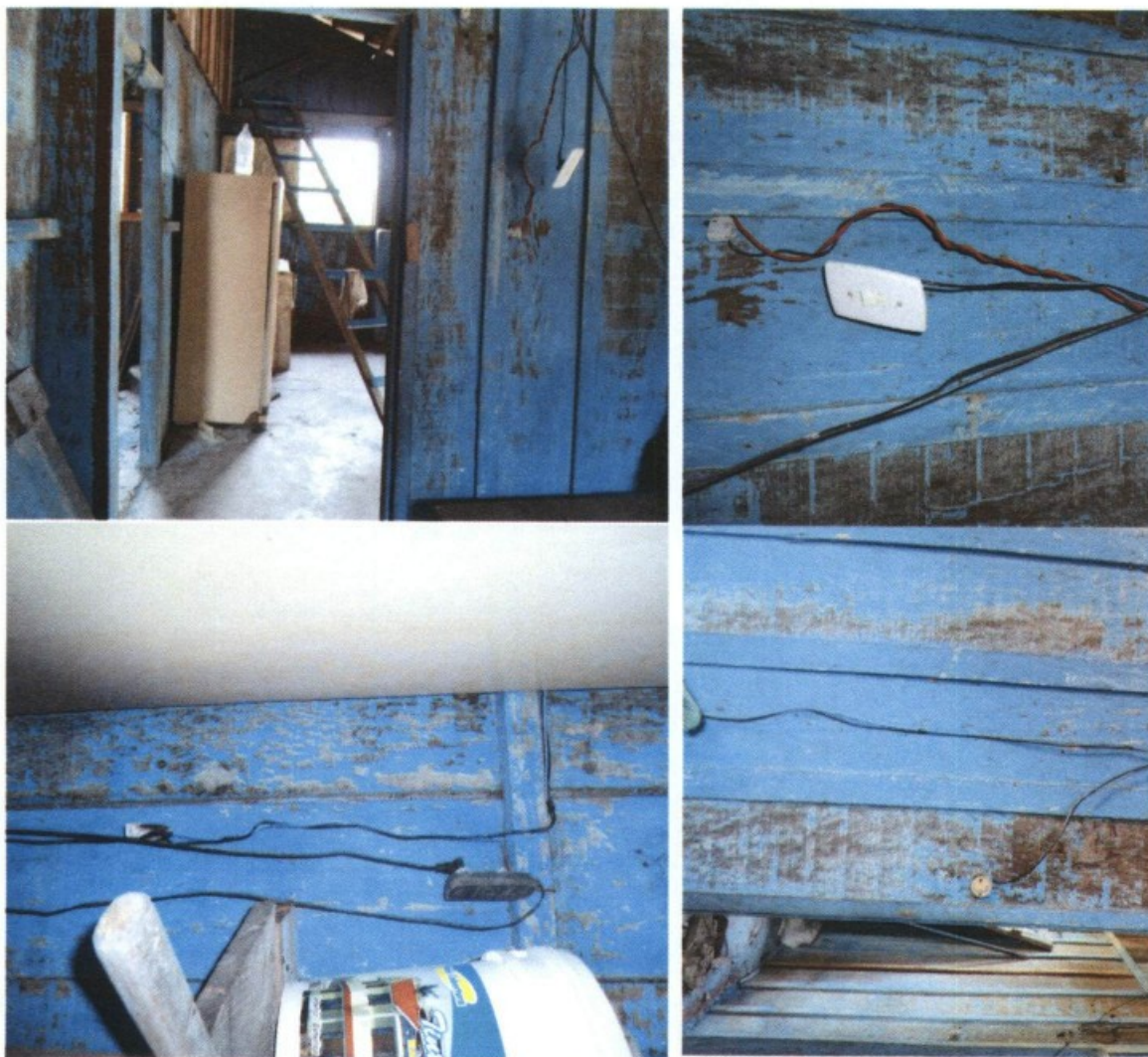
Fiação elétrica exposta na casa do Retiro Jatobá
