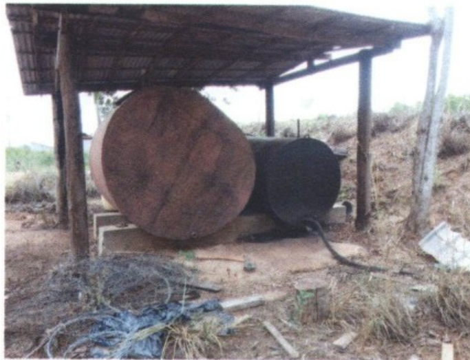
Tanque de combustível sem bacia de contenção, nas imediações da sede da fazenda.
