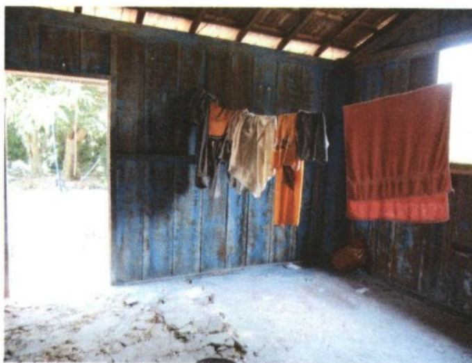
Tábuas em péssimo estado de conservação, frestas e vão na estrutura da casa utilizada para pernoite no Retiro Jatobá.
