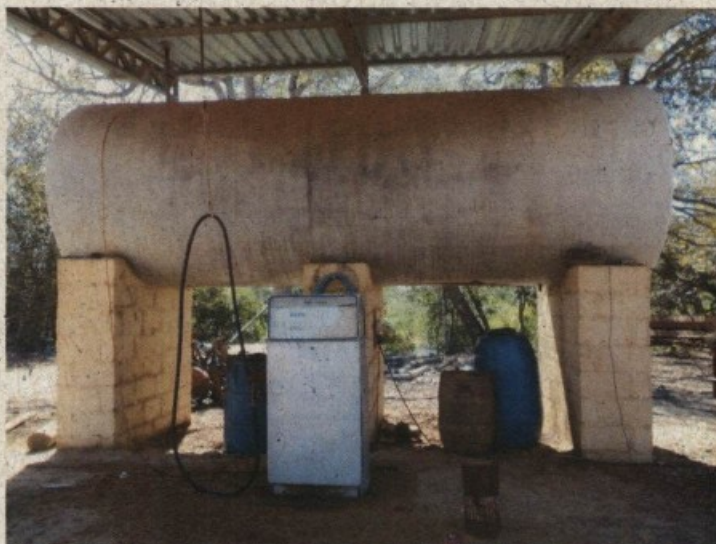
Tanque de combustível sem qualquer delimitação da área de risco.
