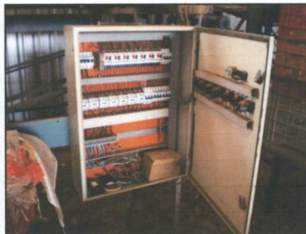
Fotos: Instalações elétricas com risco de choque.
