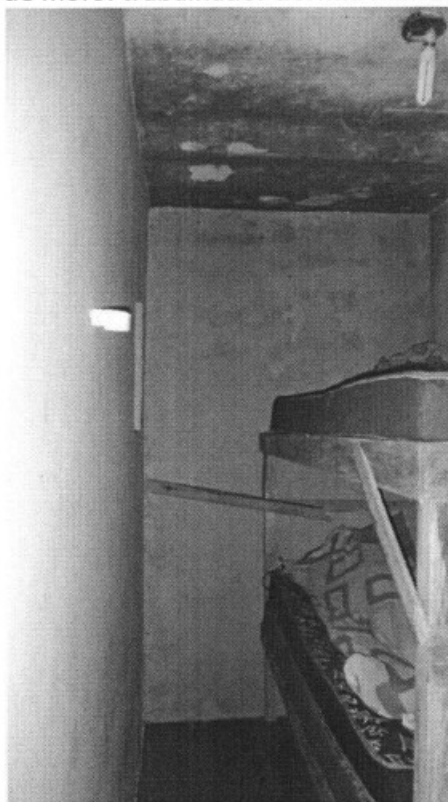
15/05/2015 – Alojamento embargado pela fiscalização. Local improvisado e de dimensões reduzidas utilizada como dormitório de dois trabalhadores. Há grande quantidade de infiltrações, umidade e mofo, prejudicando especialmente o trabalhador que dorme na parte de cima do beliche.
