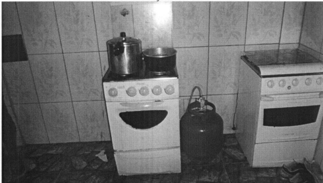
15/05/2015 – Alojamento embargado pela fiscalização. Botijão de gás dentro do alojamento, sem ventilação, com risco de explosão.
