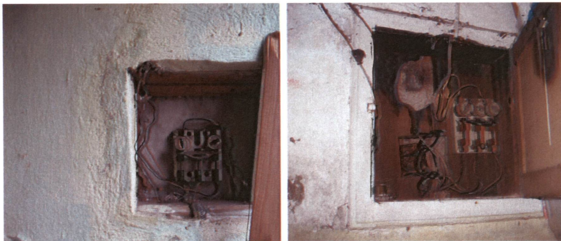
Instalações elétricas irregulares.
