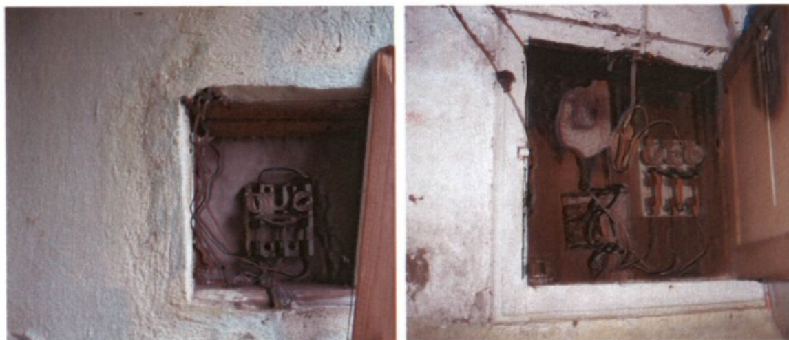
Instalações elétricas irregulares.
