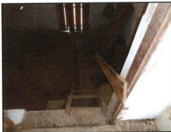
Foto: Escada sem corrimão e degraus adequados.
