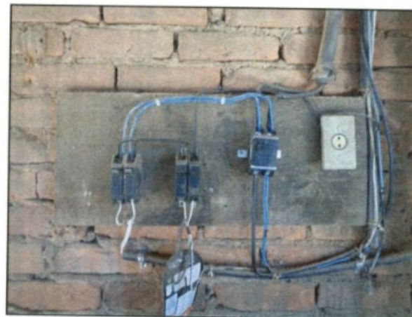
Fotos: instalações elétricas que apresentavam partes vivas expostas, com risco de choque.
