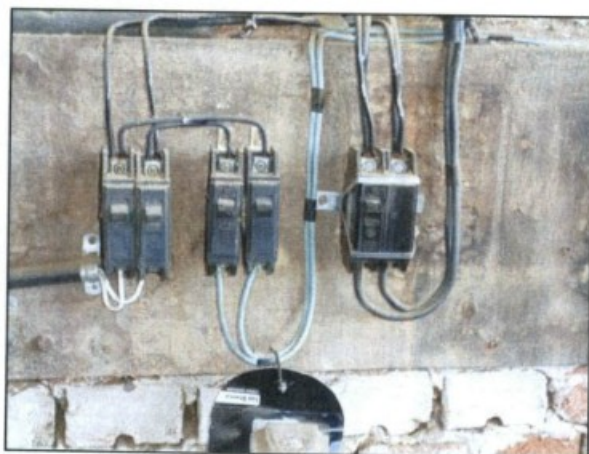
Fotos: instalações elétricas que apresentavam partes vivas expostas, com risco de choque.
