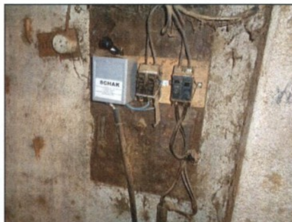
Fotos: Instalações elétricas das máquinas, apresentando riscos de choques e outros acidentes.
