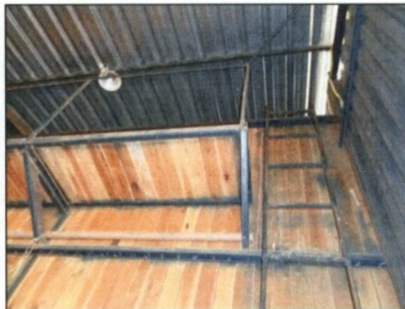
Fotos: Escada e plataforma sem guarda-corpos que protegessem contra queda.
