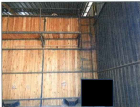
Fotos: Escada e plataforma sem guarda-corpos que protegessem contra queda.
