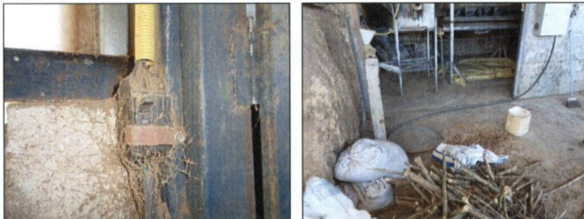
Fotos: Fios com partes vivas expostas. Cabos elétricos atravessando o local de passagem de trabalhadores.
