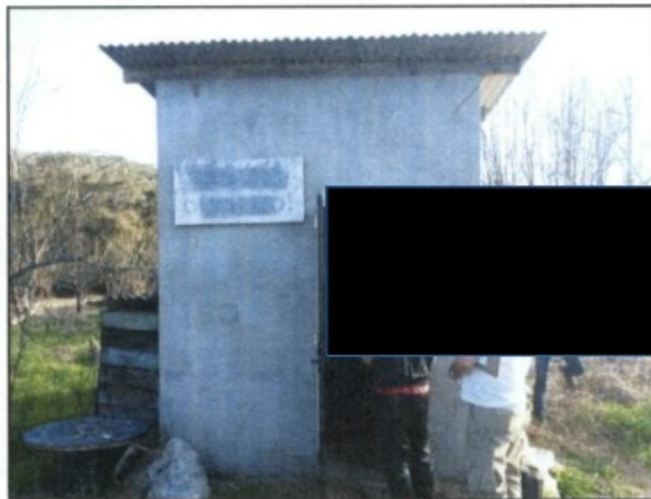
Fotos: Depósito de agrotóxicos sem ventilação para o interior.
