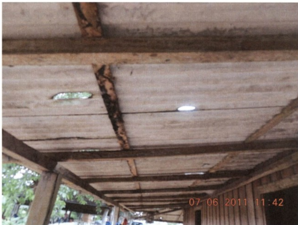
Buracos no telhado da varanda.
