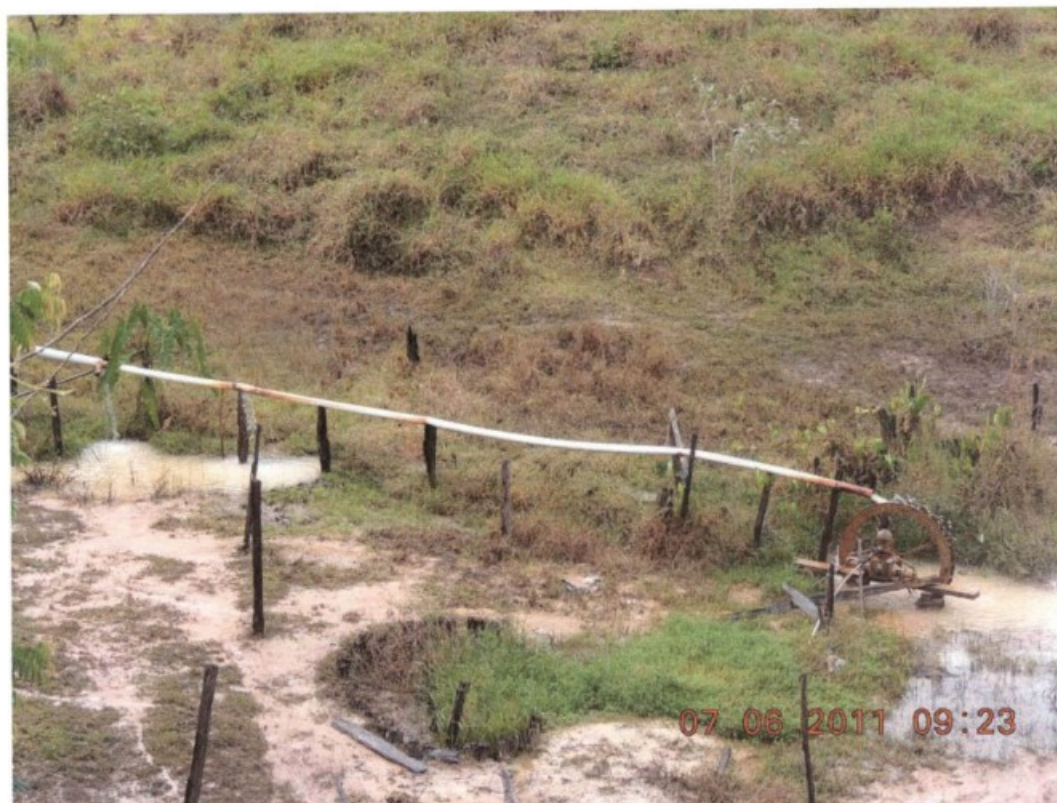
A água da barragem era canalizada, no detalhe, e levada até uma bomba d'água que a jogava para a sede da fazenda.
