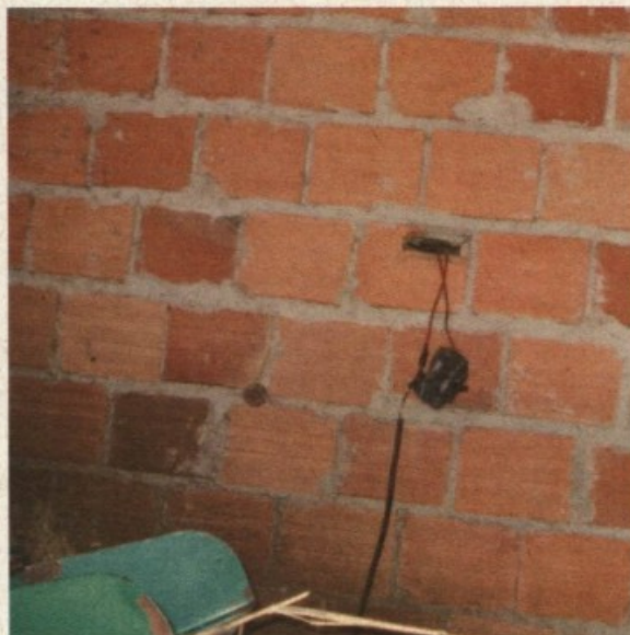
Disjuntor pendurado pelo próprio fio para ligar a máquina diretamente.
