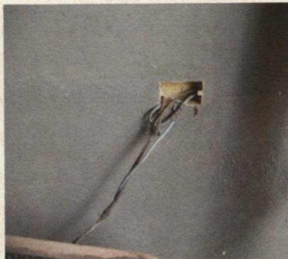
Compressor ligado diretamente à fiação, sem plugues ou tomadas.
