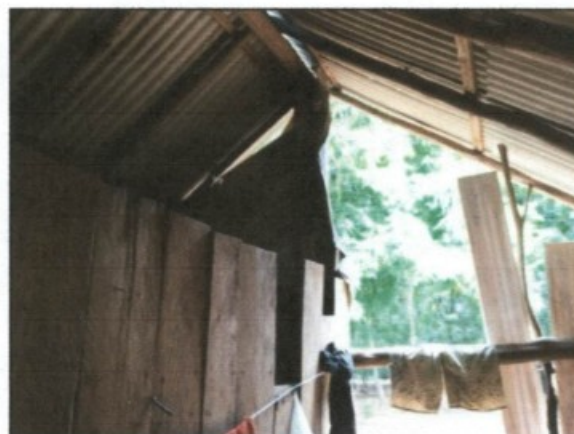
Fotos: Barraco dos cinco trabalhadores. Paredes inapropriadas, piso de terra e cobertura que não protegia contra as intempéries.
