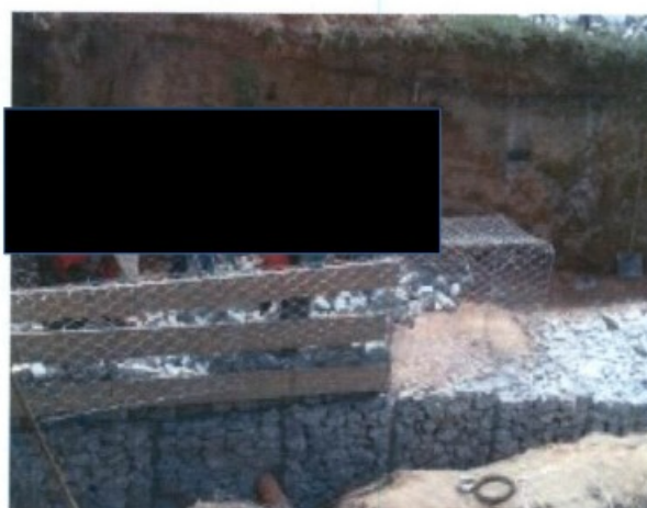
Foto obtida na internet, ilustrativa do trabalho de construção do gabião
