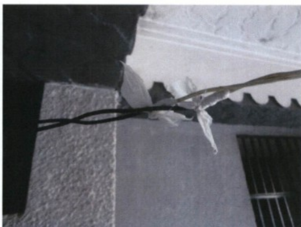
Detalhe da emenda com sacola plástica na derivação para a tomada
