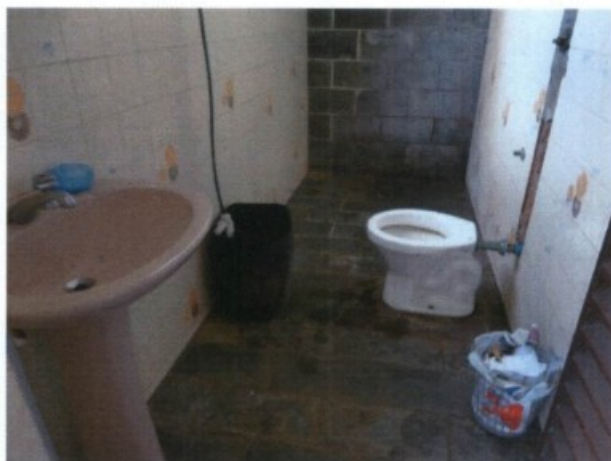
Instalação sanitária anexa à garagem, sem higienização e com descarga danificada
