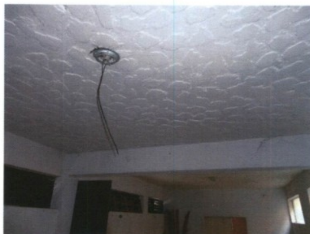
Detalhe da falta de iluminação nos cômodos anexos à garagem
