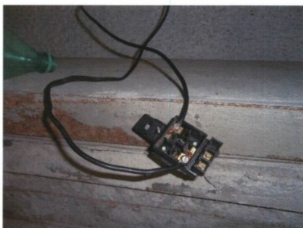
Parte posterior da tomada, com partes vivas expostas
