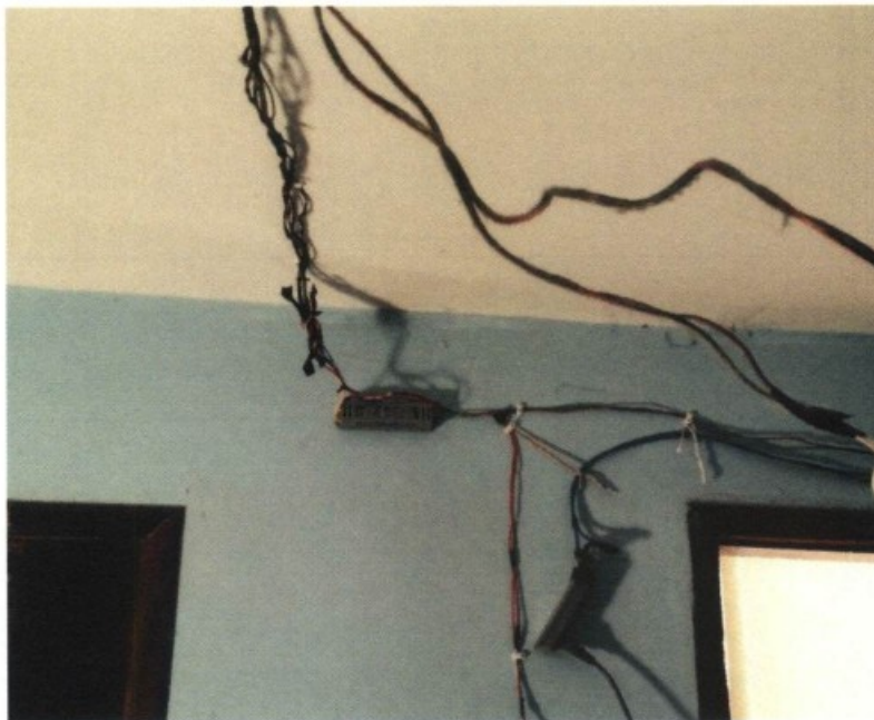
21 de setembro de 2015 – Oficina de Costura localizada na [REDACTED] [REDACTED] SP. Máquinas e equipamentos ligados a instalações elétricas precárias.
