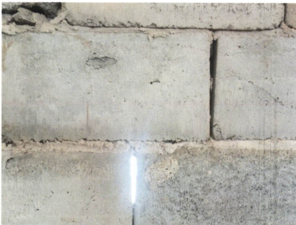
14.09.2015 – Paredes do alojamento com falhas e aberturas, permitindo a entrada de insetos e roedores e não protegendo adequadamente contra intempéries.
