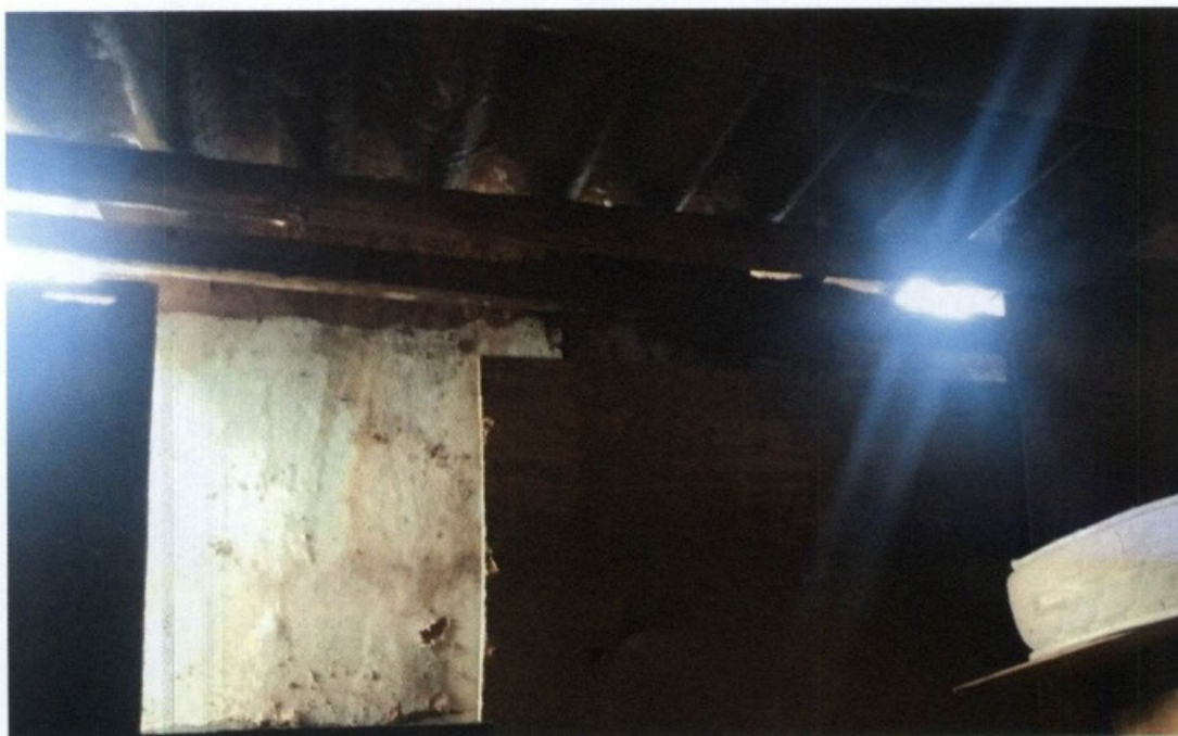
14.09.2015 – Cobertura do alojamento dos trabalhadores com falhas e aberturas.
