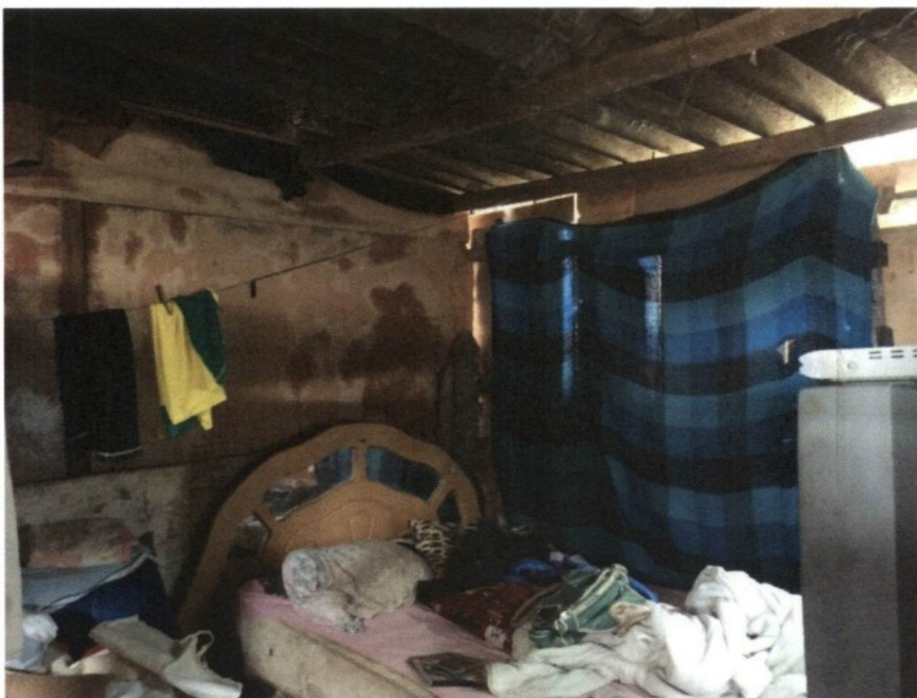
14.09.2015 – Alojamento dos trabalhadores não possuíam janelas. Paredes de pedaços de madeira improvisados, de material inadequado, grande quantidade de umidade e mofo.
