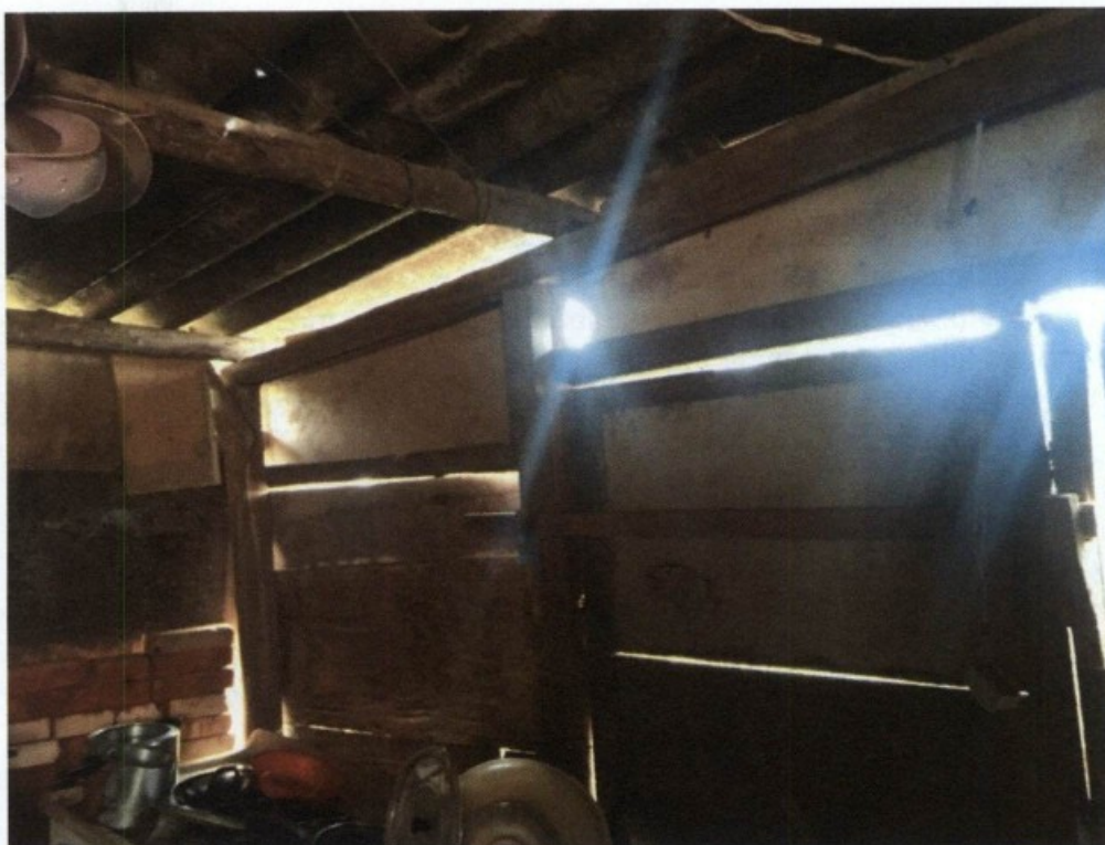
14.09.2015 – Paredes do alojamento com falhas e aberturas, o que permite a entrada de insetos e roedores, além de não proteger adequadamente seus ocupantes de intempéries, como chuva.
