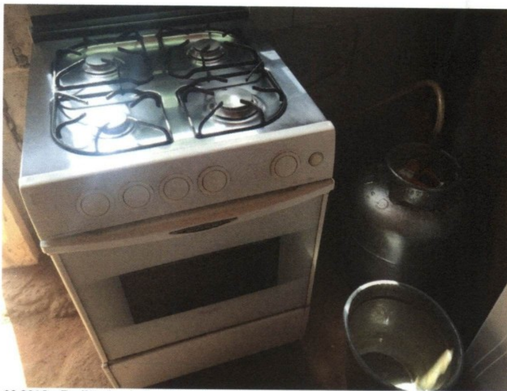
14.09.2015 – Botijão de gás liquefeito de petróleo instalado em local inapropriado, sem ventilação adequada, oferecendo risco de explosão aos ocupantes do alojamento. Balde de água utilizado para beber e fazer as refeições era retirado de poço a 50 metros do local.
