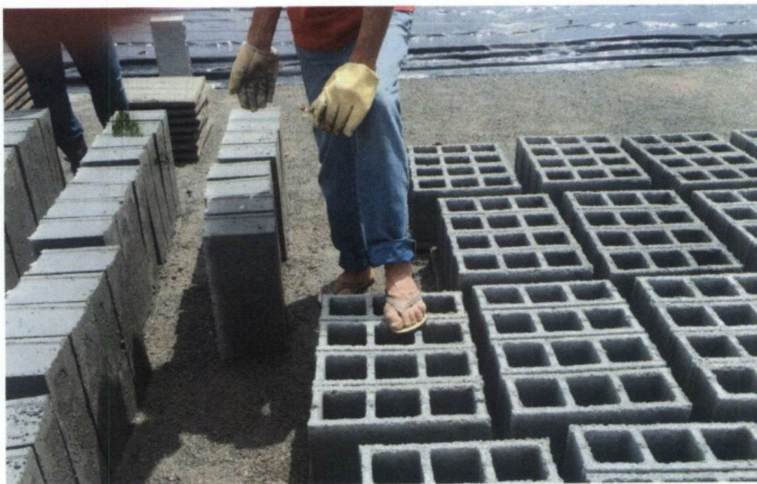
14.09.2015 – Falta de equipamentos de proteção individual, como botas: trabalhador encontra-se de chinelos.
