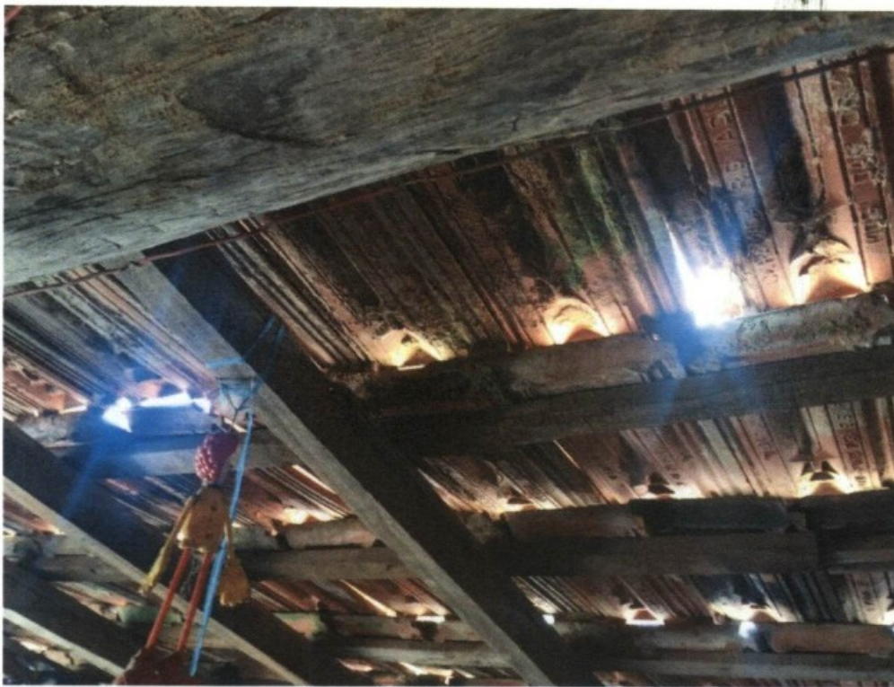
14.09.2015 – Cobertura do alojamento com falhas e aberturas, permitindo a entrada de insetos e roedores e não protegendo adequadamente contra intempéries.
