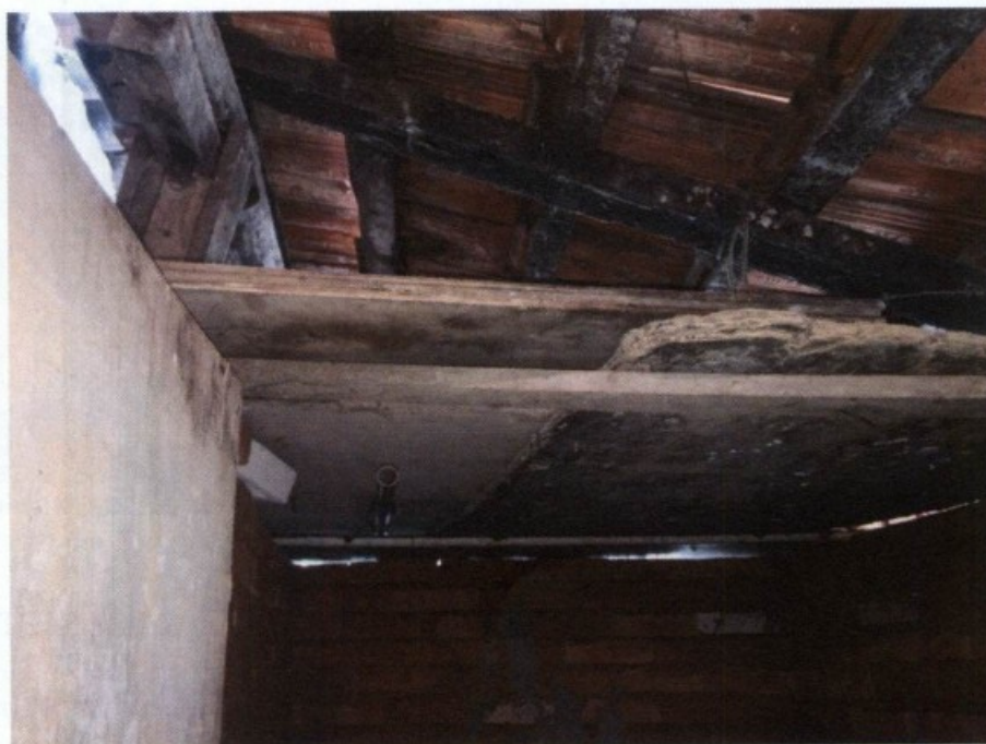
14.09.2015 – Instalações Sanitárias utilizadas pelos trabalhadores. Figura mostra o chuveiro, que consistia em um cano suspenso a aproximadamente 2 metros de altura; cobertura com falhas nas telhas e aberturas; o forro foi improvisado com tábuas de madeiras.
