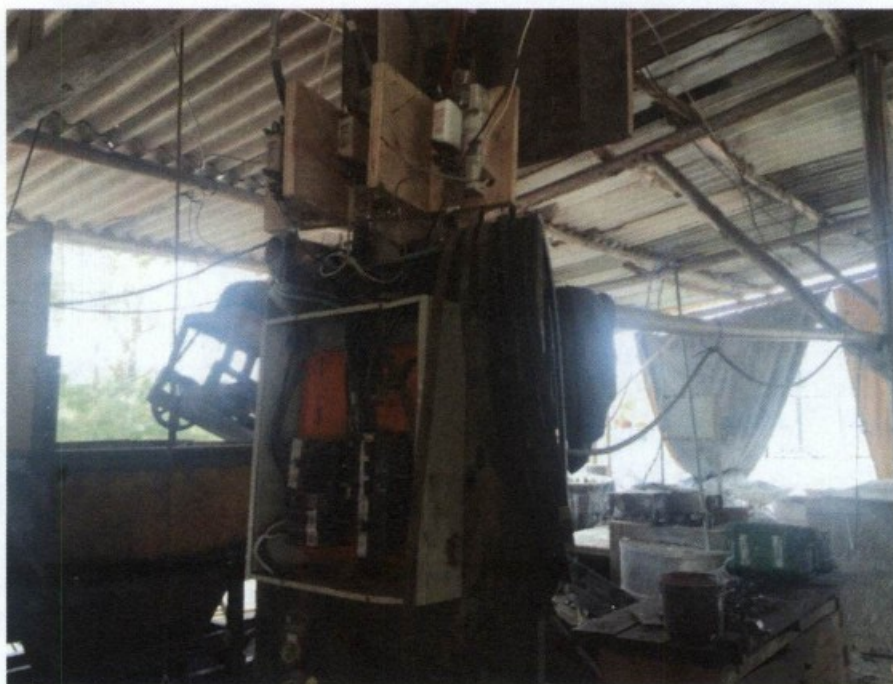
14.09.2015 – Quadro de energia sem proteção, aberto, com os fios expostos e com ligações irregulares: risco grave e iminente de choques elétricos.
