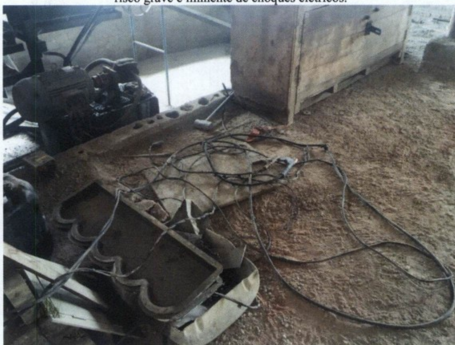
14.09.2015 – Cabos energizados espalhados na área de trabalho: risco grave e iminente de choques elétricos.
