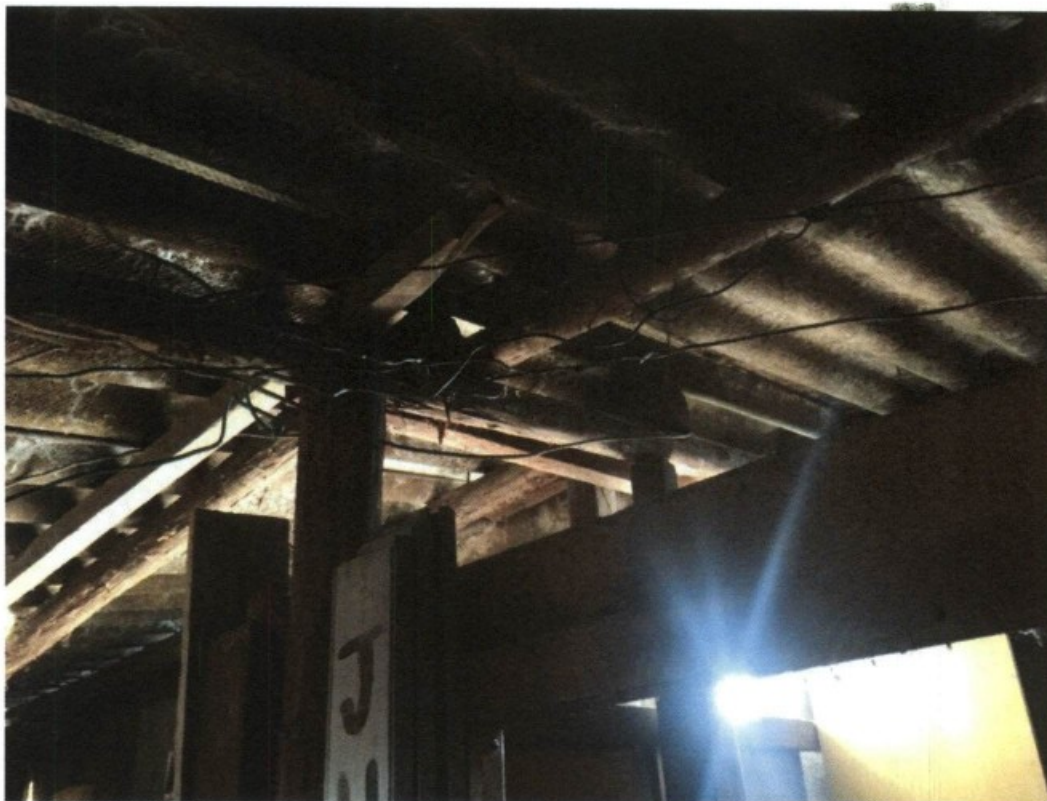
14.09.2015 – Instalações elétricas totalmente inadequadas no alojamento dos trabalhadores. Fiação aparente e com as partes vivas expostas. Ligações feitas de material inadequado. Risco de choques e incêndio.
