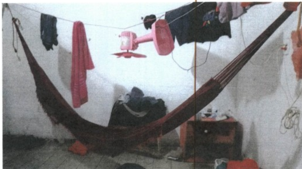
"Gambiarras" com condutores elétricos fora de eletrodutos
