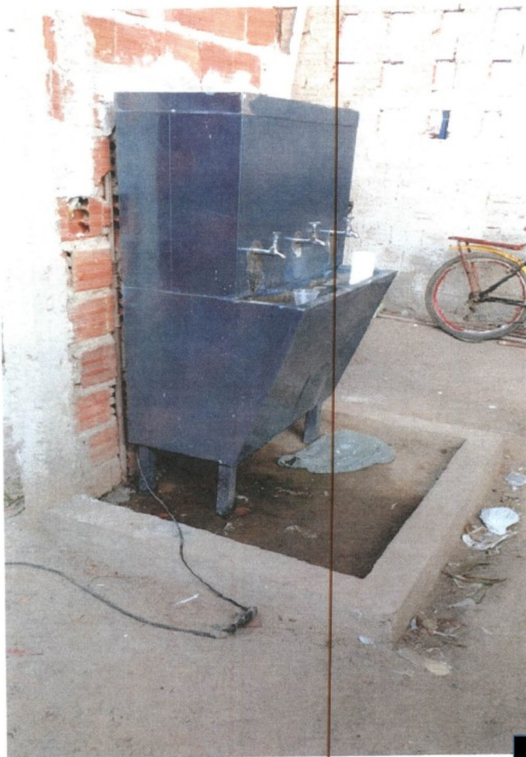
Bebedouro instalado no refeitório em construção sem aterramento elétrico
