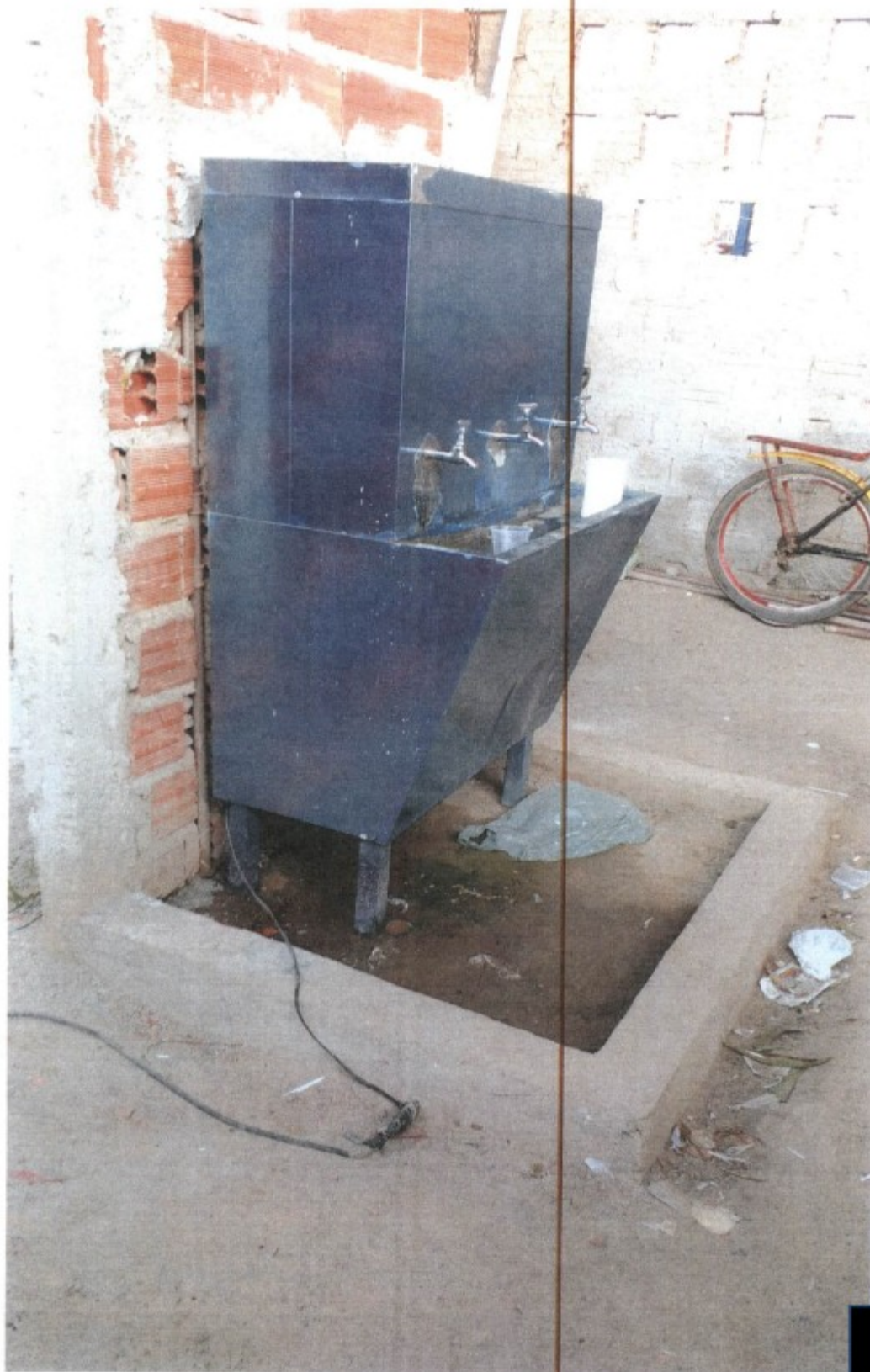
Bebedouro mantido em local com formação de área molhada
