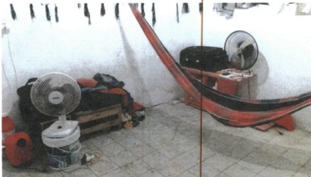
Condutores fora de eletrodutos, espalhados dentro dos quartos e servindo para conectar vários equipamentos elétricos
