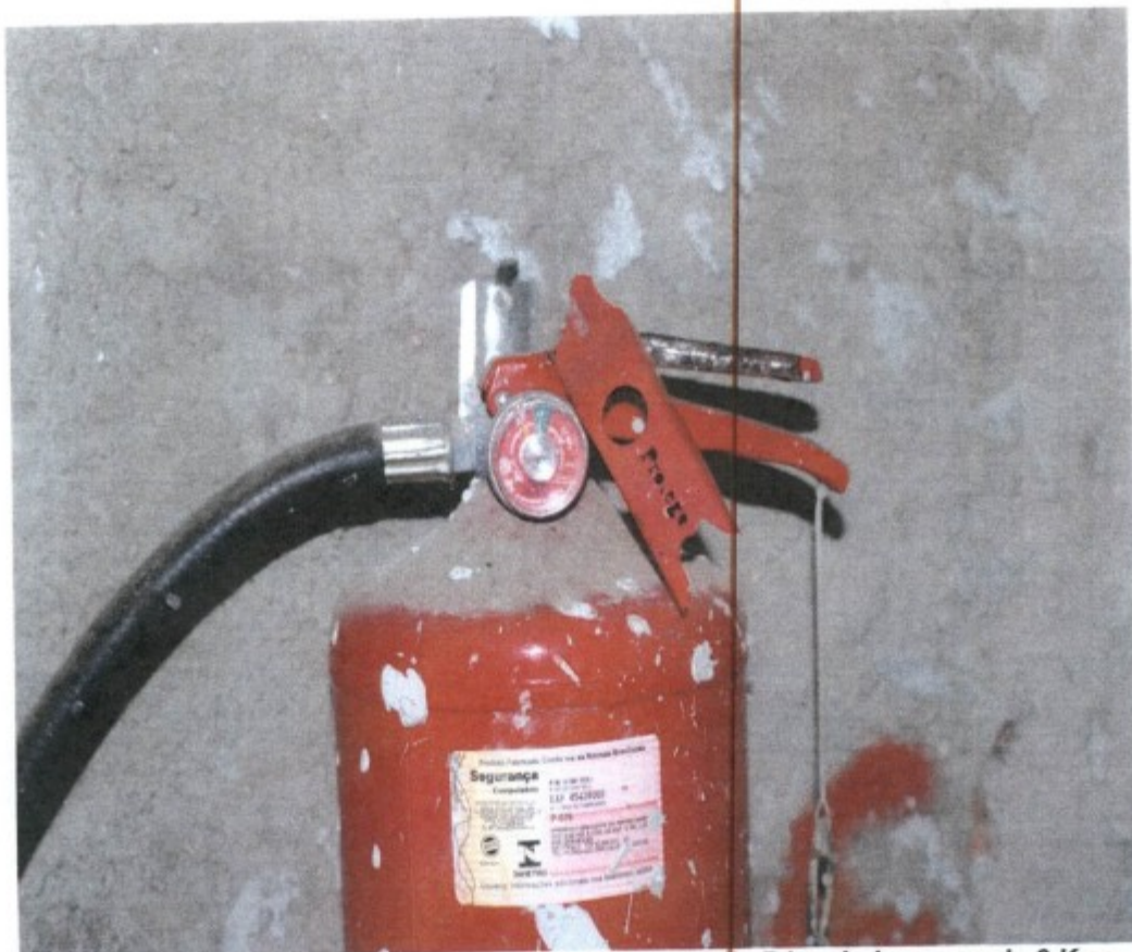
Extintores da área de vivência descarregados: 01 de Pó químico seco de 6 Kg e 01 de Água pressurizada de 10 l
