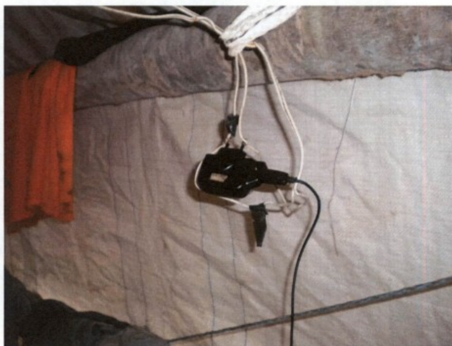
Fig.: Detalhe da gambiarra elétrica dentro do barraco.
