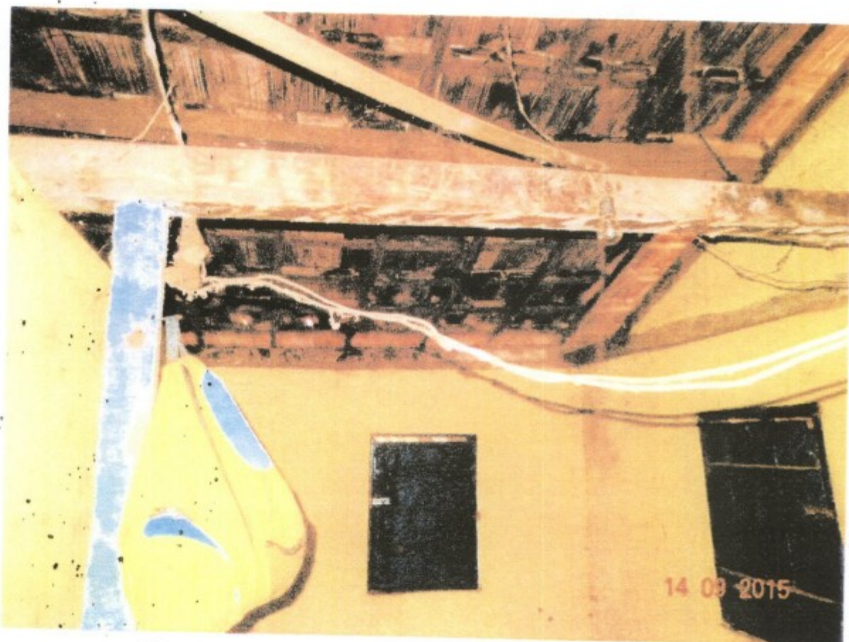
Teias de aranha, sujeira e fiação elétrica com partes vivas expostas
