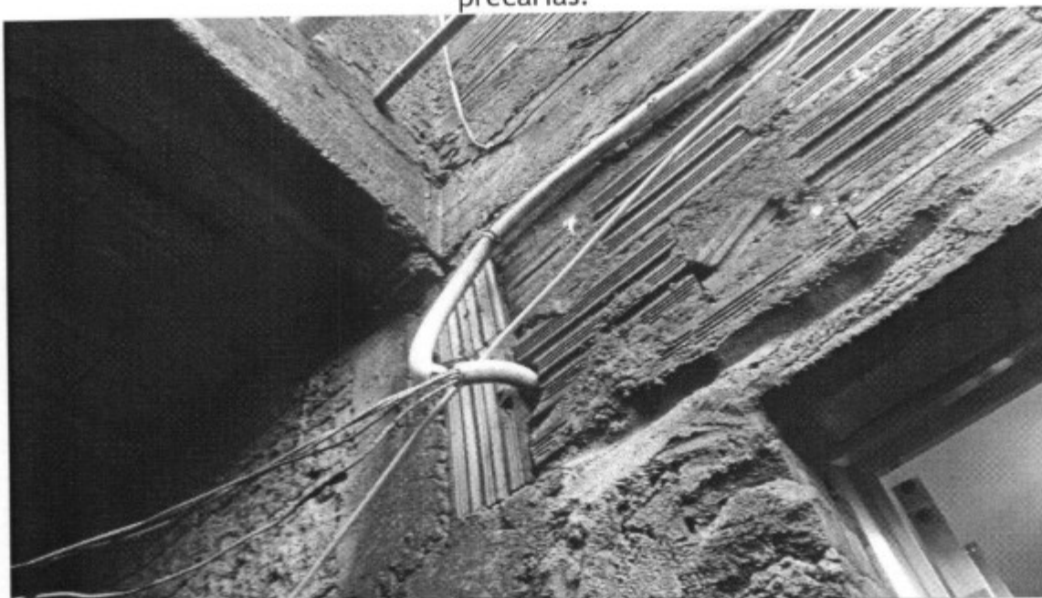
03/07/2015 - Alojamento da Rua [REDACTED] Teto sem acabamento e com instalações elétricas precárias.
