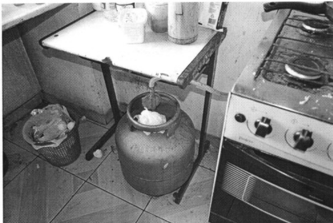
03/07/2015 - Alojamento da [REDACTED] Botijão de gás GLP instalado dentro do alojamento, sem ventilação adequada.
