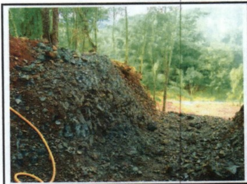
Figura 12 – Local de trabalho onde estavam sendo realizadas explosões sem qualquer tipo de sinalização.
