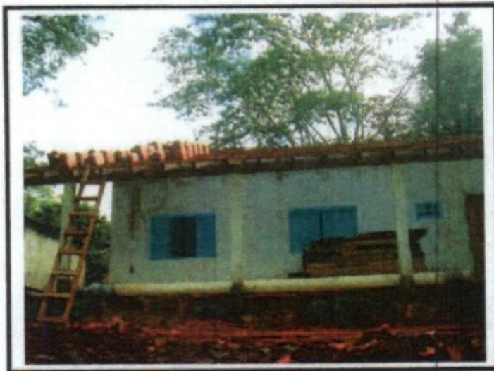
Figura 8 - Casa que servia como depósito, área de vivência, etc. O telhado foi destruído, haja vista a utilização de explosivos sem as pressupostos estabelecidos em lei para salvaguardar a saúde e a segurança dos obreiros, dentre estes proteger a área de fogo contra projeção de partículas na operação de desmonte de rocha.
