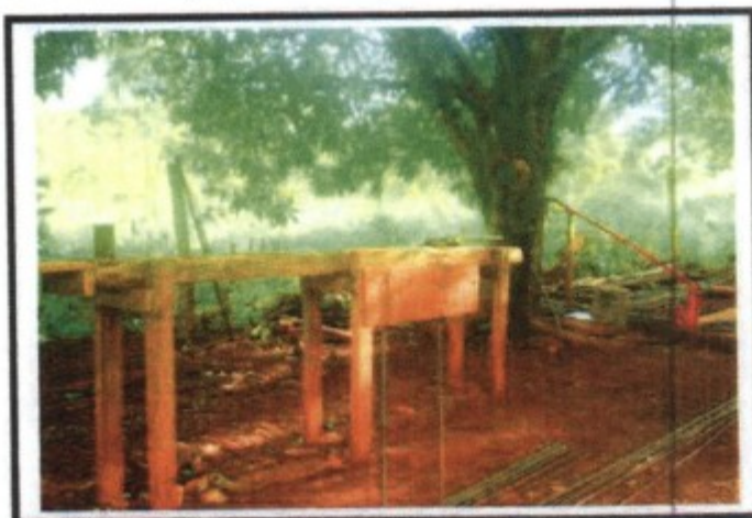
Figura 10 - Bancada de armação, sem proteção contra intempéries e queda de materiais.
