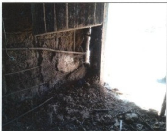
portas que não vedam - frestas nas paredes externas, facilitando entrada de animais selvagens
