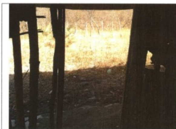
portas que não vedam - frestas nas paredes externas, facilitando entrada de animais selvagens
