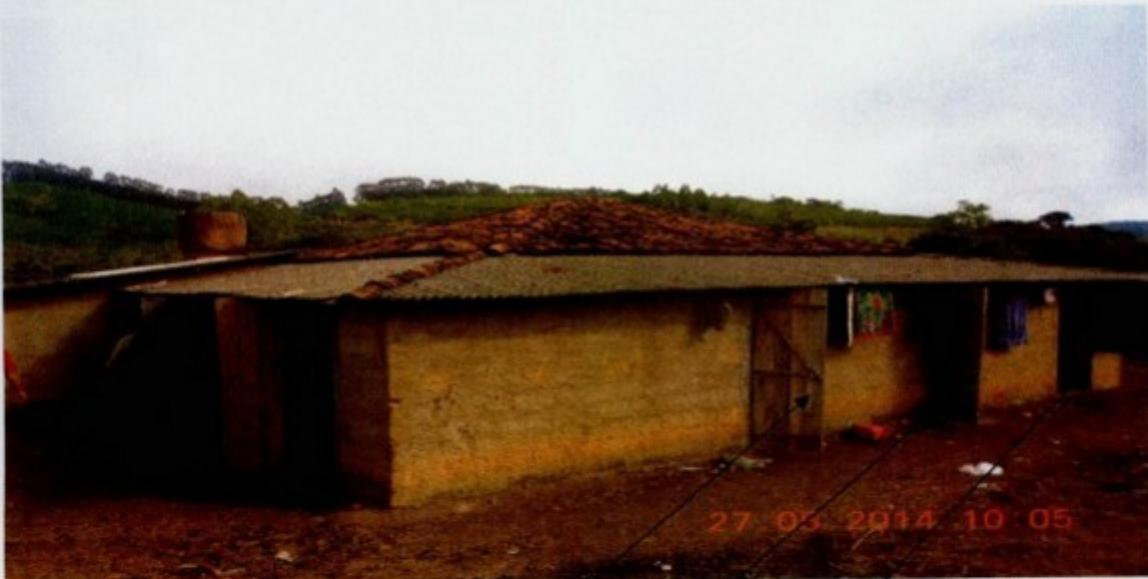
Mostrando os três cômodos, utilizados como quartos, medindo 1,80 m x 2,20 m, e que não possuíam nenhum tipo de janelas para iluminação e ventilação.
