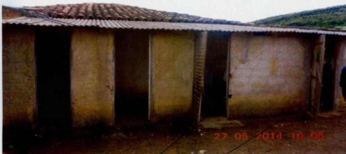
Mostrando os dois cômodos, utilizados como quartos, medindo 1,80 m x 1,90 m, e que não possuíam nenhum tipo de janelas para iluminação e ventilação.
