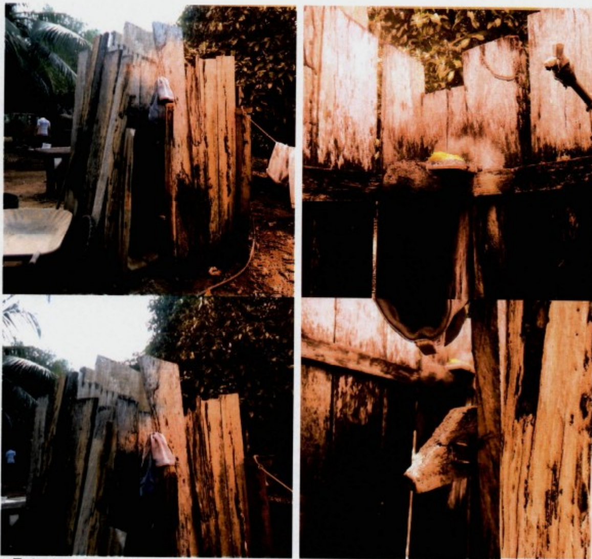
Estrutura improvisada para banho. Sem cobertura, sem porta e de tábuas com fendas. No detalhe, pregos na madeira.
