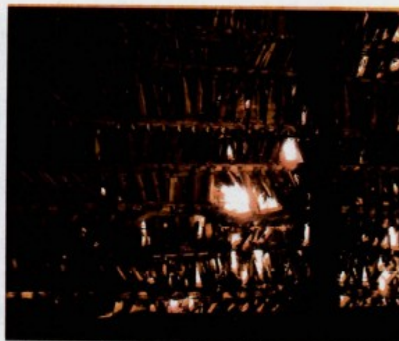
Chão de terra. Frestas entre as tábuas da parede de madeira e buracos na cobertura de palha.
