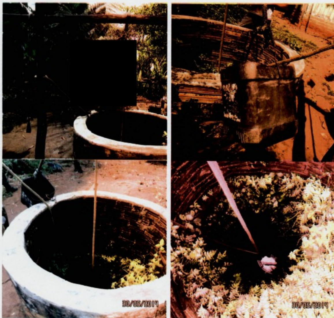
Poço mantido desprotegido contra contaminações. Vegetação crescendo em seu interior.
