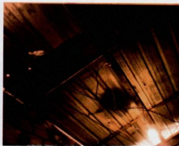
Fiação exposta em local ainda em construção onde permanecia o trabalhador [REDACTED]
