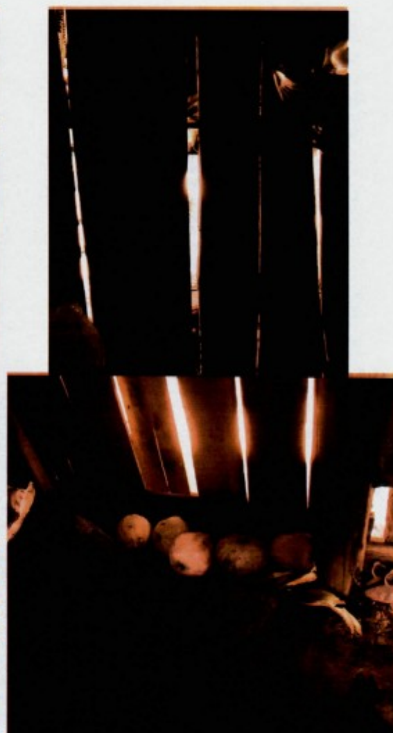
Detalhes do barraco do trabalhador [REDACTED] e sua companheira. Chão de terra, frestas entre as tábuas da parede, aberturas na cobertura de palha e grande vão entre as tábuas da parede e a cobertura.
