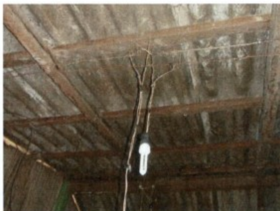
Foto - Fiação elétrica exposta
