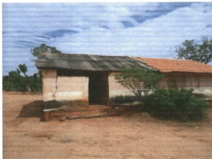
Foto 01. Casa na qual os trabalhadores ficaram alojados.
