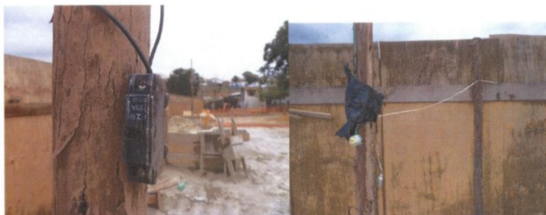
Instalações elétricas com partes vivas expostas
