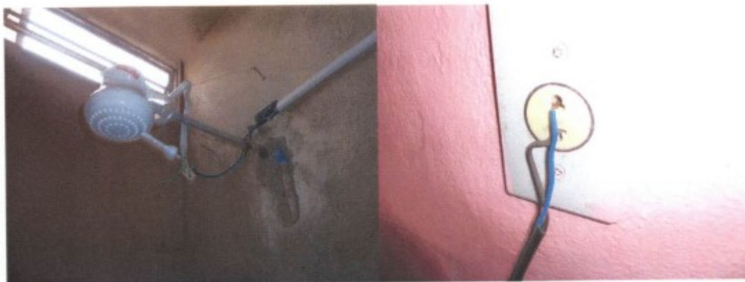
Chuveiro elétrico sem aterramento e gambiarra elétrica
