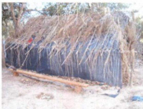
Imagem 01 – vista externa dos alojamentos destinados aos trabalhadores
