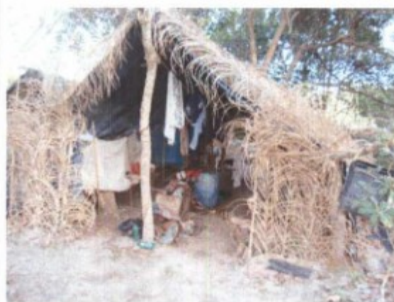
Imagem 02 – vista externa dos alojamentos destinados aos trabalhadores
