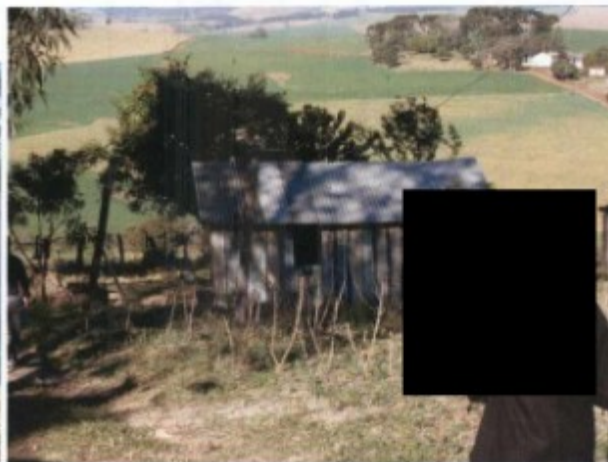
Vista externa do casebre de madeira, com cobertura de brasilit, de chão batido e frestas nas paredes.
