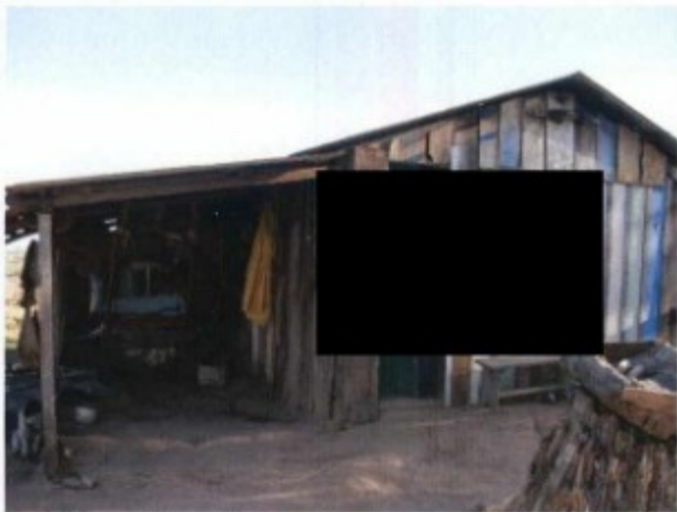
Vista externa do casebre de madeira, com cobertura de brasilit, de chão batido e frestas nas paredes.
