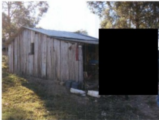
Vista externa do casebre de madeira, com cobertura de brasilit, de chão batido e frestas nas paredes.
