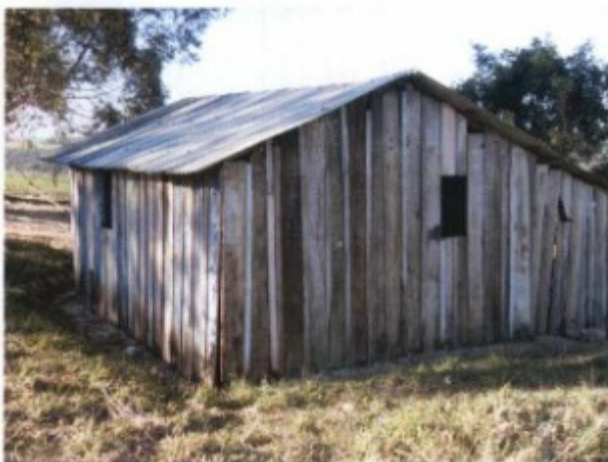
Vista externa do casebre de madeira, com cobertura de brasilit, de chão batido e frestas nas paredes.
