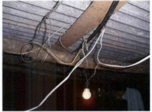
Instalações elétricas oferecendo risco de choque e incêndio
