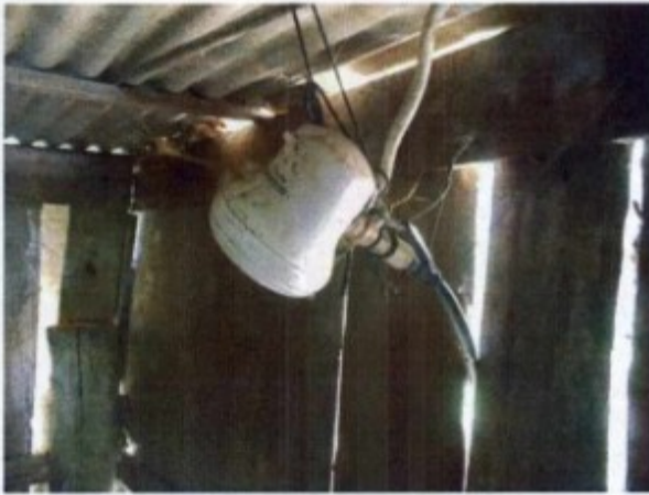
Instalações elétricas oferecendo risco de choque e incêndio
