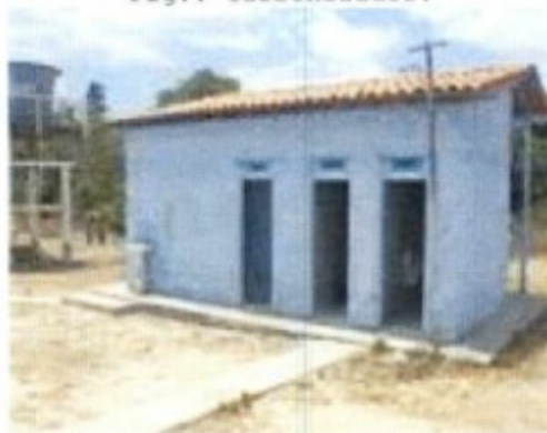
Fig.: Instalações sanitárias.
