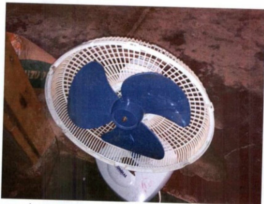
Figura 07 – Único ventilador existente no alojamento, para amenizar ventilação insuficiente (inexistência de janelas laterais) e o ataque de pernilongos. Percebe-se ainda a guarda de material de construção (cimento) no interior do alojamento. Também existiam vergalhões espalhados no interior.
